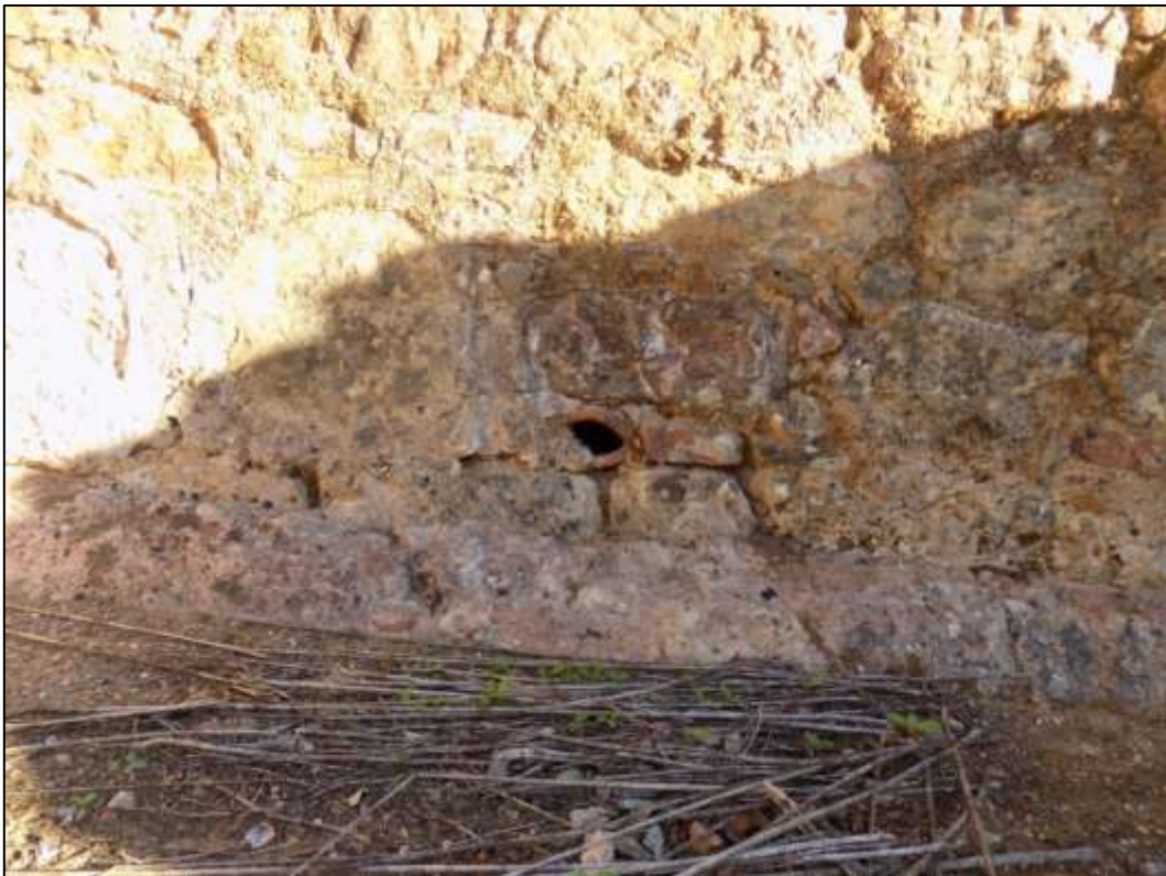
Fig. 96 - Abertura no paramento Oeste da Sala 15 para a passagem de uma canalização de adução de água. Vista Este
