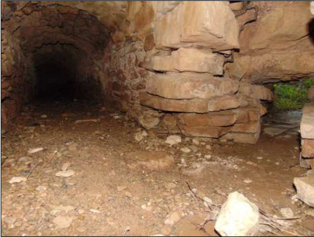
Fig. 127 - Ponto de escoamento da canalização C53 visto do interior da C56. Vista Sudeste
