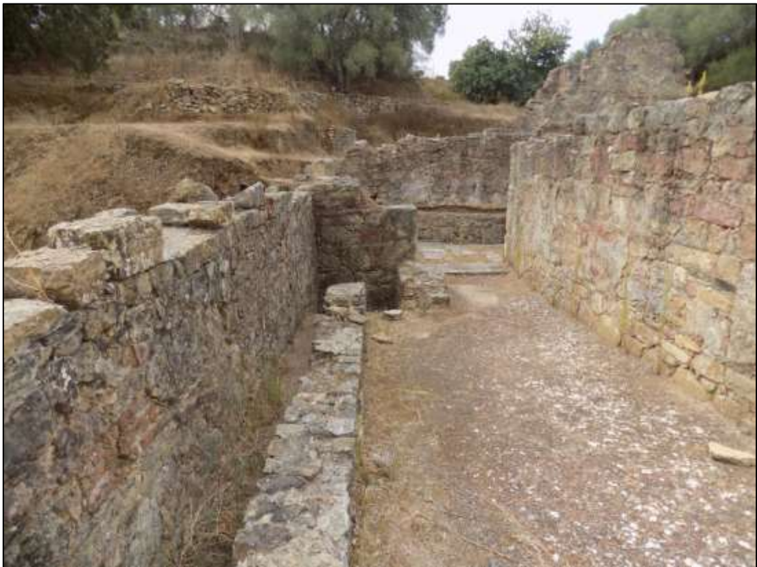
Fig. 102 - Canalização C34 e entrada de manutenção C33 (ao fundo). Vista Sul
