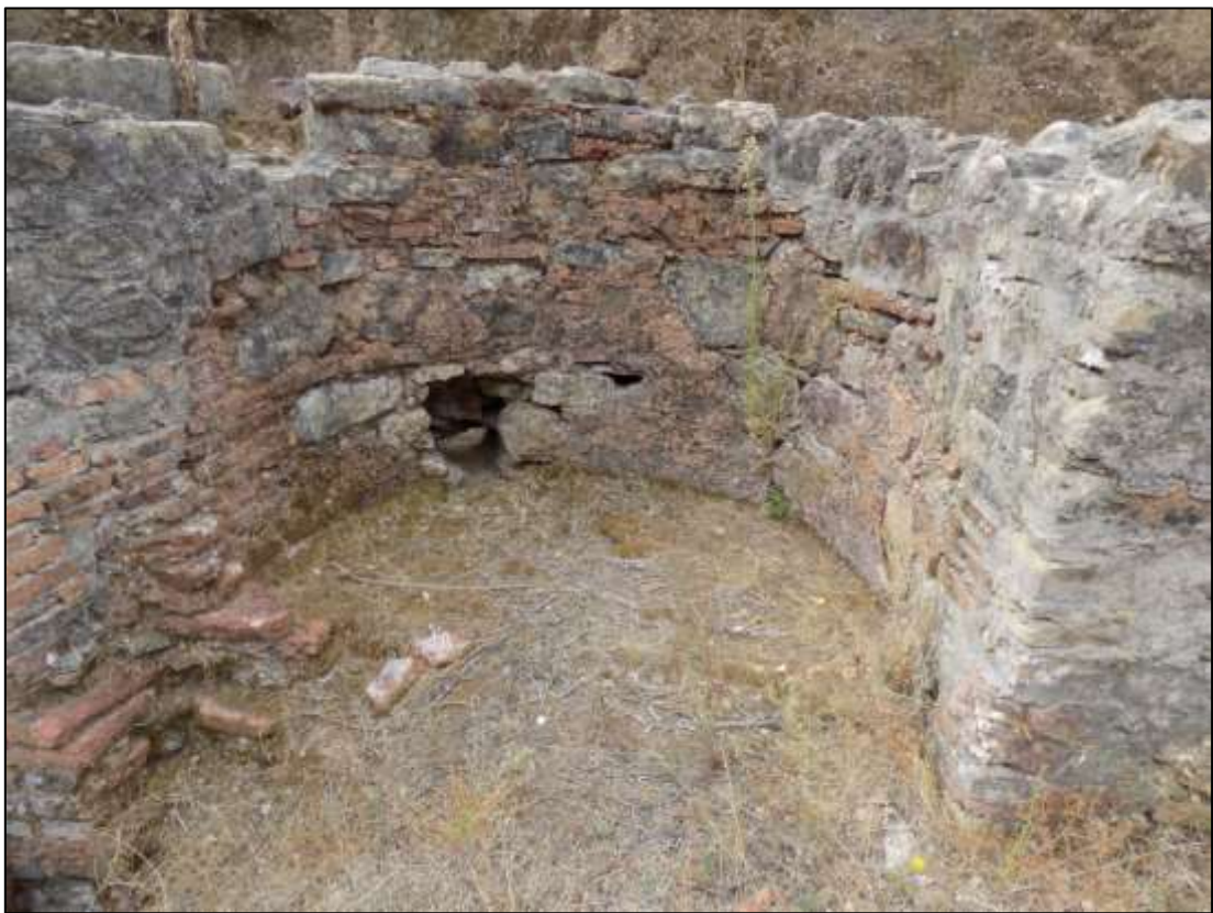
Fig. 94 - Unidade estratigráfica negativa resultante da extracção da canalização C48 (esquerda) e abertura no paramento para a passagem da canalização de adução de água ao tanque (direita). Vista Sul
