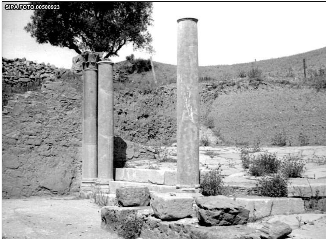
Fig. 151 - Estrutura de impermeabilização C51, ainda com revestimento lateral parcialmente conservado. Vista Noroeste. Sem data (Acervo fotográfico da DGEMN)
