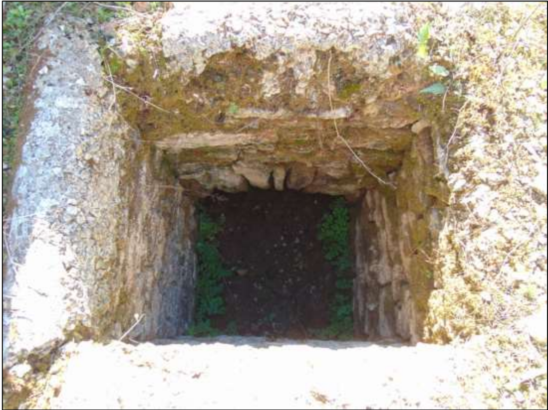
Fig. 110 - Entrada para manutenção C23, rodeada de uma meia-cana em opus signinum, e canalização C56 (ao fundo). Vista Sul
