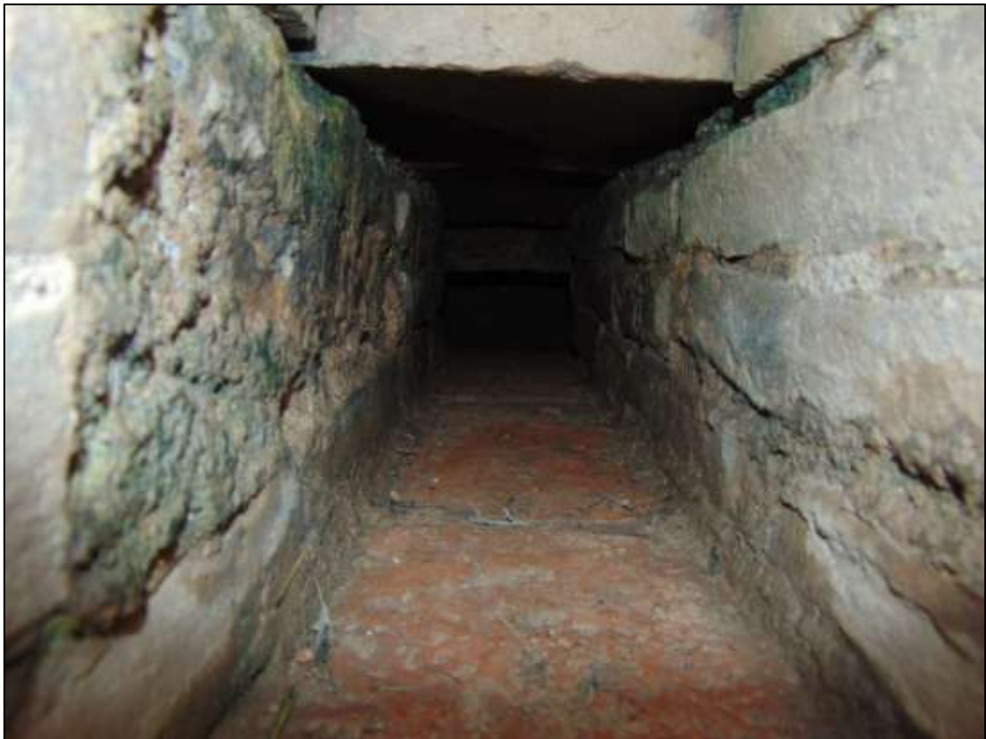
Fig. 121 - Interior da canalização C27. Vista Oeste
