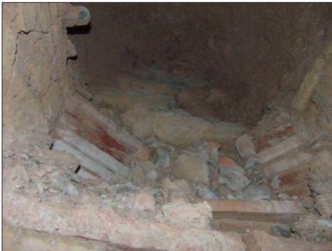
Fig. 139 - Interior do sumidouro C61, obstruído. São visíveis duas estruturas em alvenaria de tijolo e um paramento em alvenaria de pedra, localizados a Sul do edifício termal, ainda ocultos.
