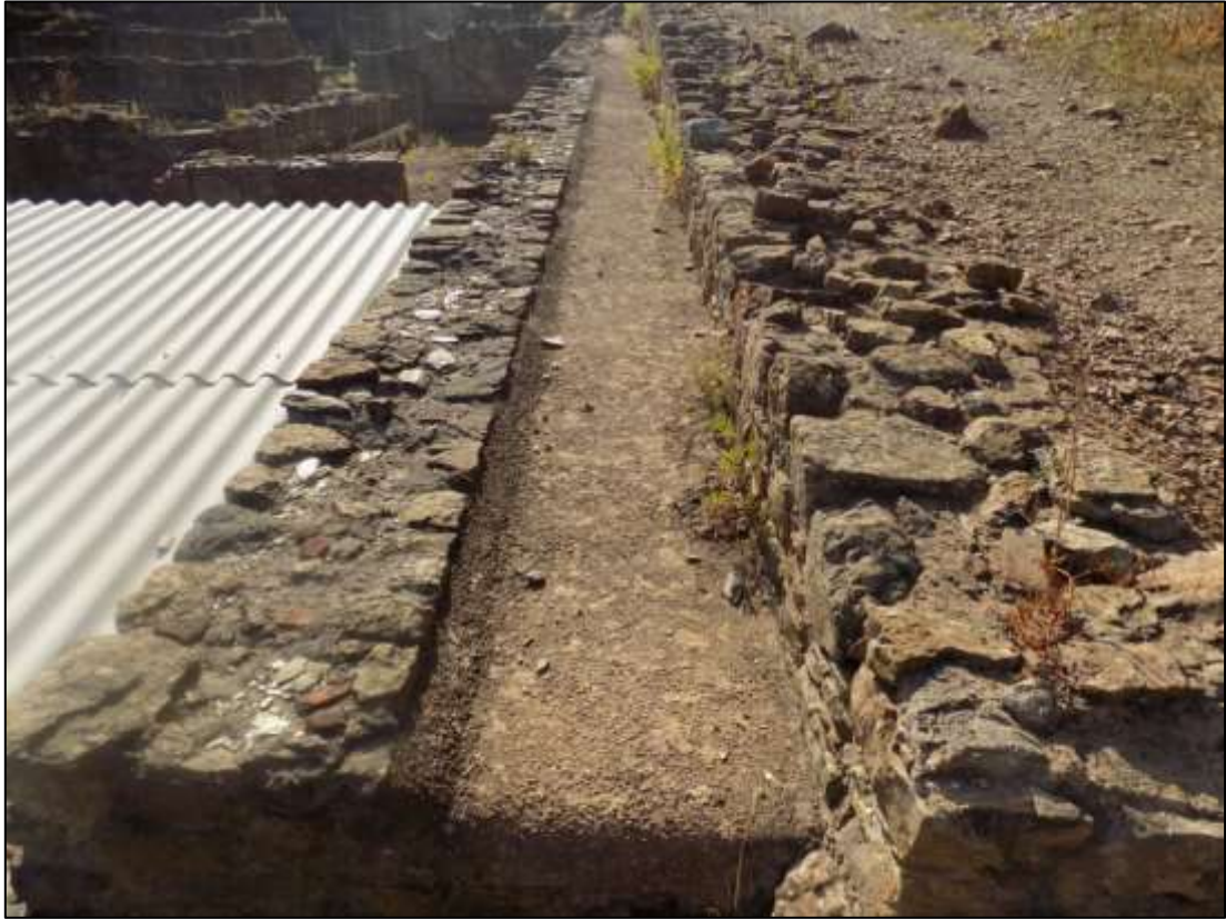
Fig. 89 - Limite Este da estrutura de impermeabilização C38. Vista Oeste
