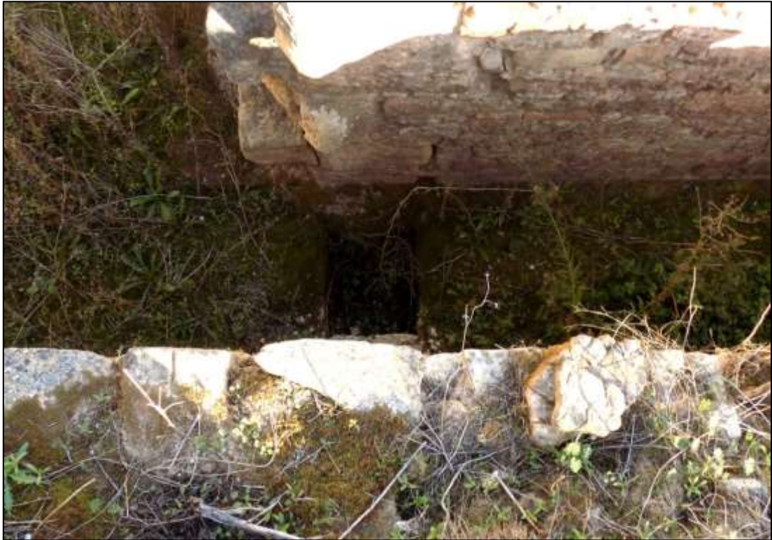
Fig. 129 - Sumidouro C24. Vista de Topo
