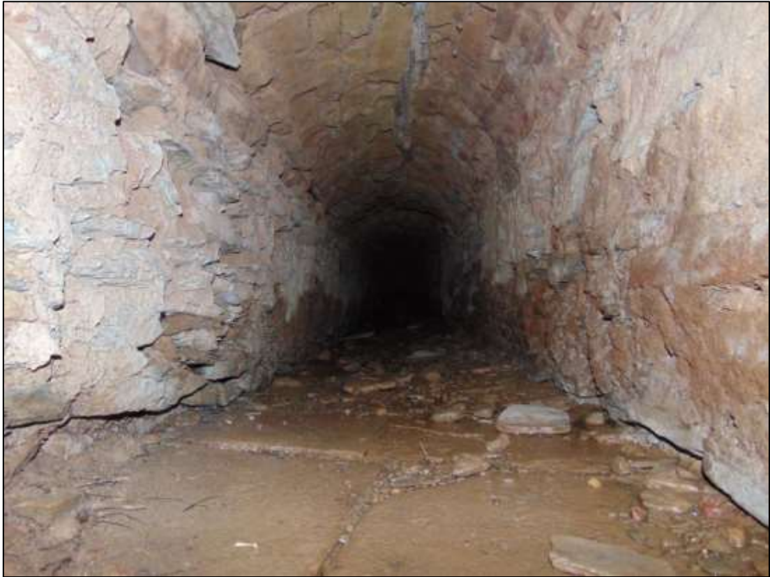
Fig. 108 - Interior do troço Sul da canalização C56. Vista Oeste
