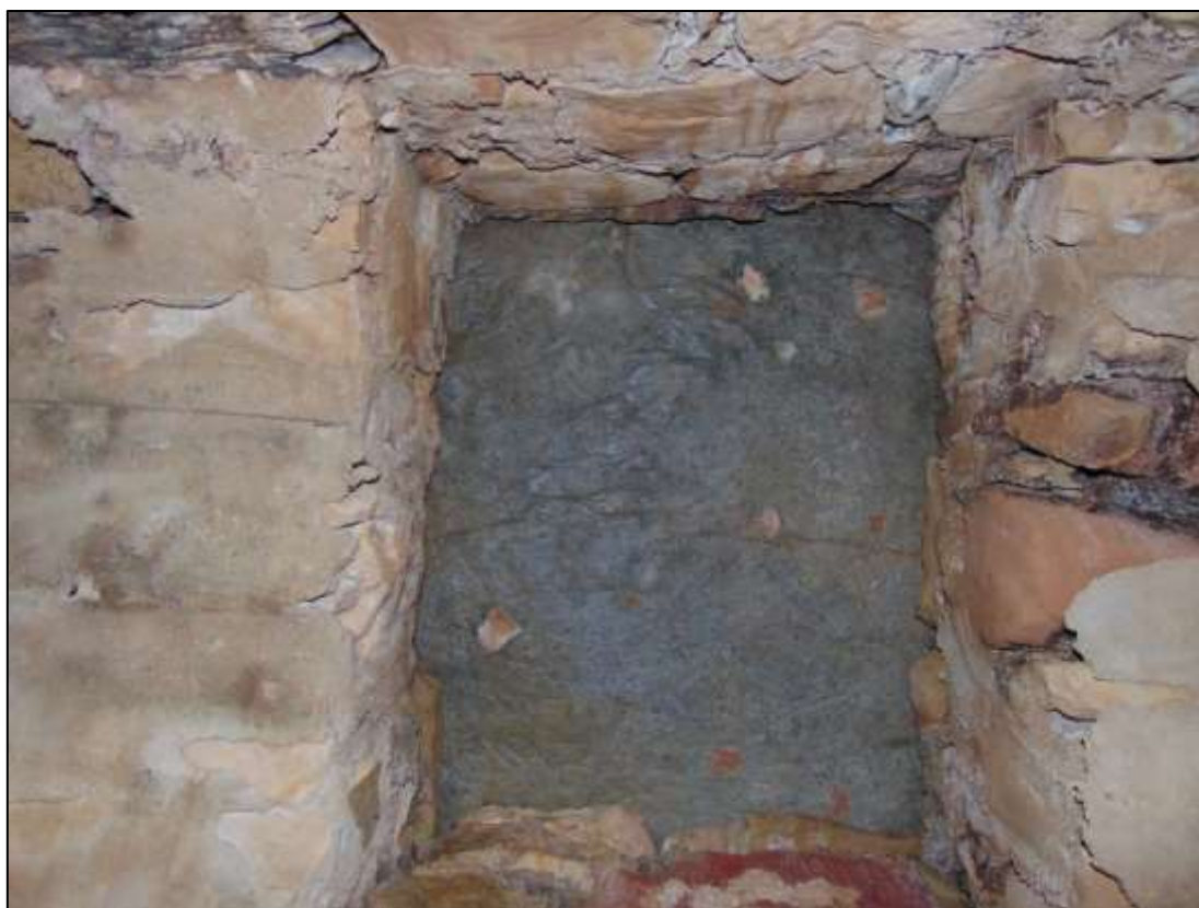
Fig. 134 - Interior do sumidouro C58, selado com uma placa de cimento contemporâneo.
