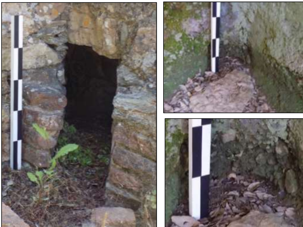
Fig. 74 - (esquerda) Ponto de escoamento da canalização C46. Vista Noroeste
