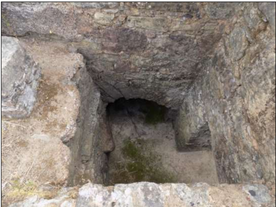
Fig. 109 - Entrada de manutenção C33. Sendo visível a canalização C34 (esquerda), C35 (centro) e o canal principal da Latrina Oeste, C43, (direita). Vista Este
