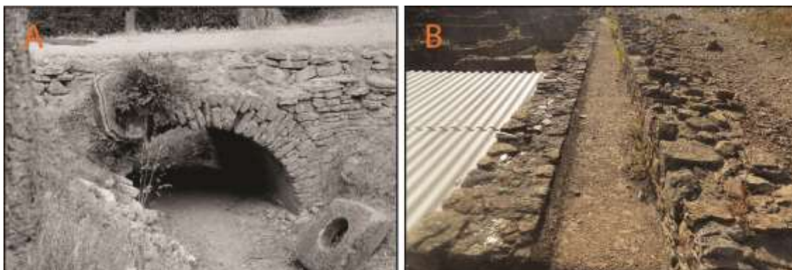
Fig 1 - A - Ponte (Via X) e bocal de poço em 1959. Vista Sudeste (Acervo fotográfico da DGEMN); B - Estrutura C38. Vista Oeste
