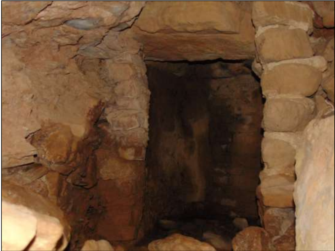
Fig. 147 - Interior do troço reformulado da C56. É visível o muro construído com tijolo e ligante contemporâneo para evitar o colapso da canalização (fundo direita). Vista Oeste
