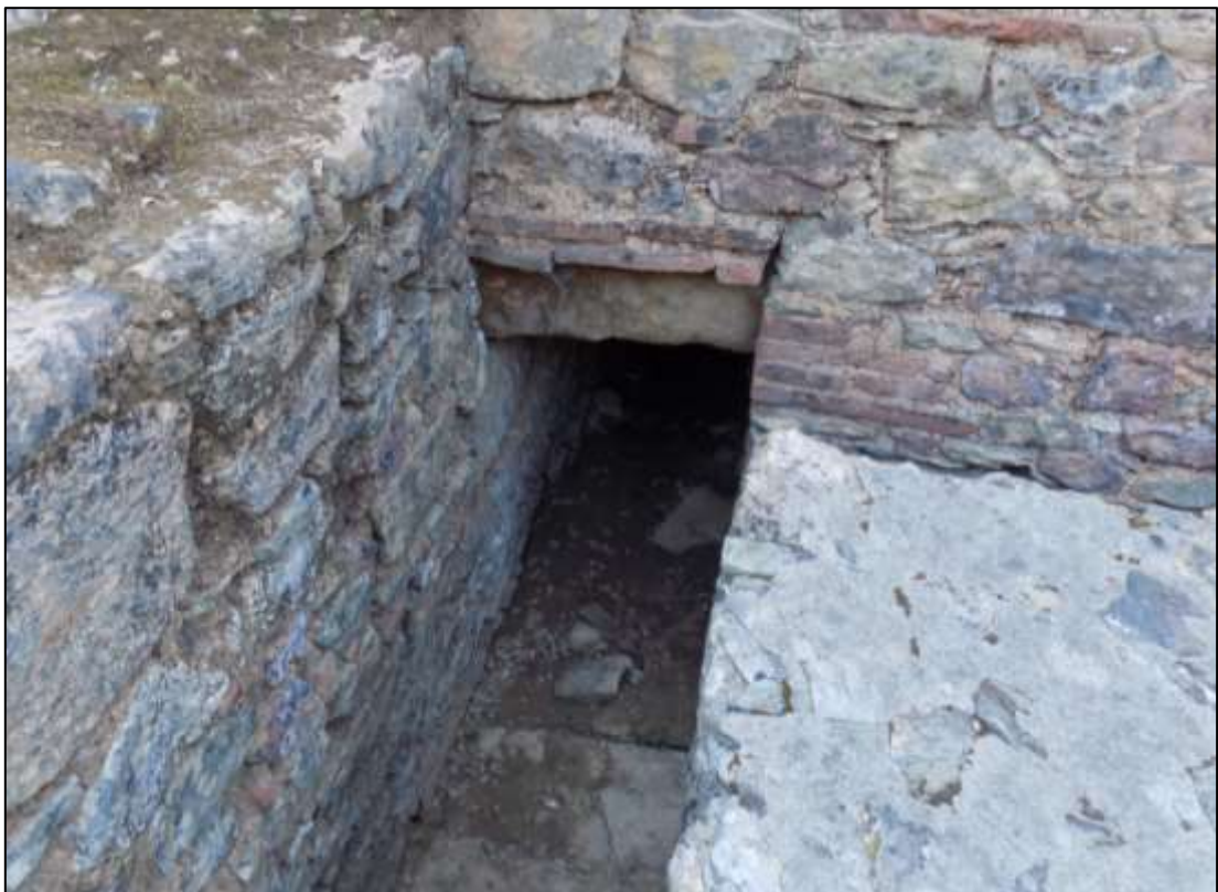
Fig. 165 - Troço Este do canal principal da latrina C43 e ponto de escoamento da C56. Vista Sul
