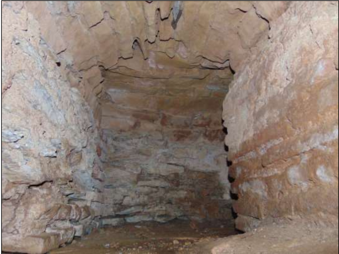
Fig. 107 - Interior da canalização C56 na zona em que esta curva para Oeste, contornando a zona de serviço aos praefurnia . Vista Sudoeste
