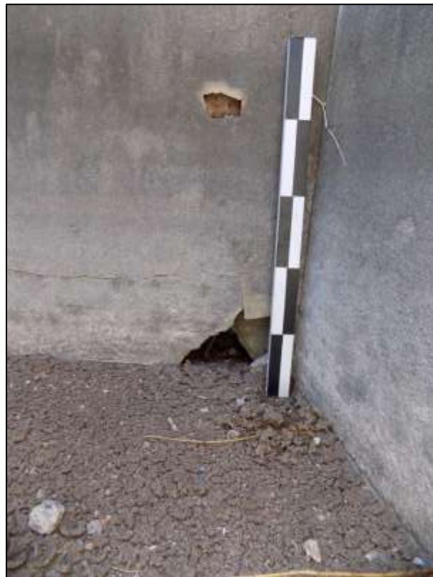
Fig. 157 - Orifício em laje marmórea que oculta a canalização C30. Vista Noroeste
