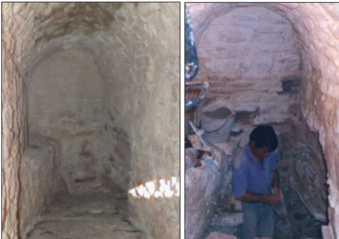
Fig. 142 - (esquerda) Interior da C25 junto ao seu limite Norte. São visíveis os indícios de reformulação e o aspecto actual do sumidouro C26. Vista Nordeste
