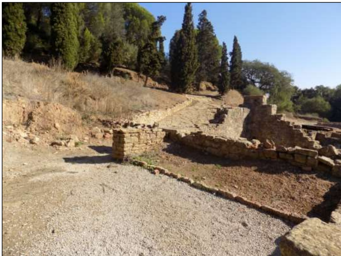
Fig. 152 - Estrutura de impermeabilização C52. Vista Este
