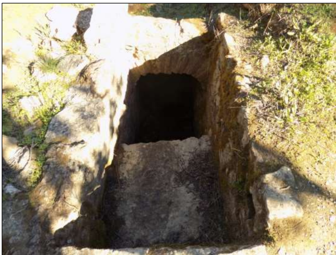
Fig. 140 - Entrada para manutenção e sumidouro C37. Vista Nordeste
