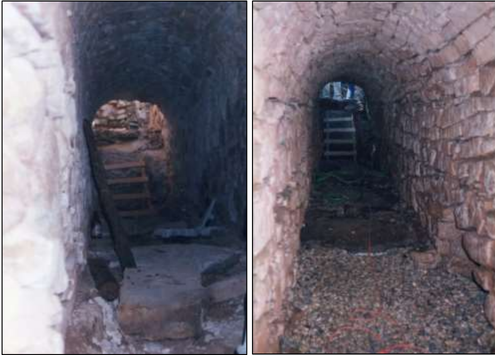
Fig. 144 - (esquerda) Interior da C25 durante os trabalhos de restauro de 1998 Vista Sudoeste Fig. 145 - (direita) Interior da C25 durante os mesmos trabalhos de restauro. Vista Sudoeste (Acervo fotográfico de Mirobriga )
