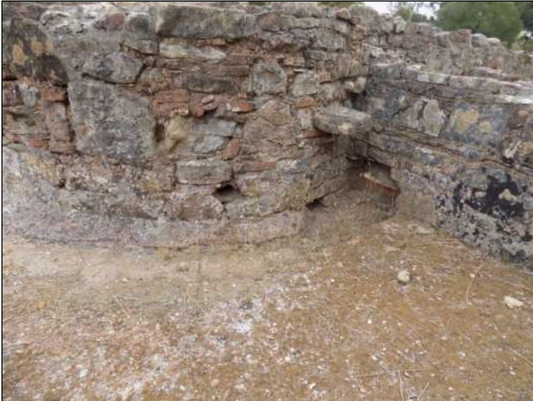
Fig. 95 - Unidade estratigráfica negativa resultante da extração da canalização C48 (esquerda) e abertura no paramento para a passagem da canalização de adução de água ao tanque (centro). Vista Nordeste
