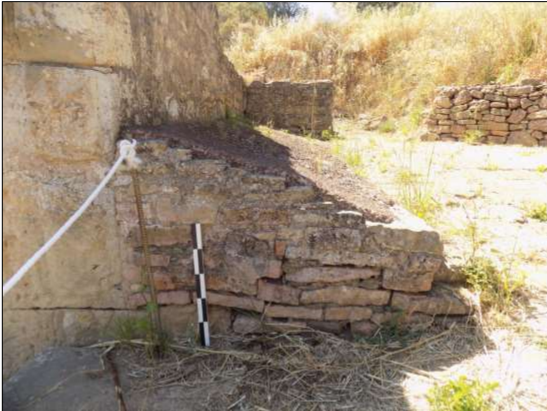
Fig. 149 - Estrutura de impermeabilização C51. Vista Oeste
