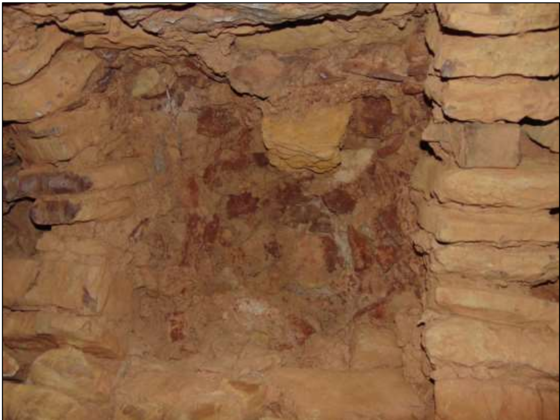
Fig. 132 - Interior do sumidouro C57, obstruído, sendo visível o limite de um pavimento em opus signinum que existirá à superfície
