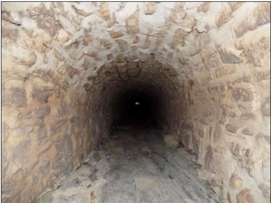
Fig. 72 - Interior da canalização C35. Visível restauro contemporâneo (topo). Vista Este
