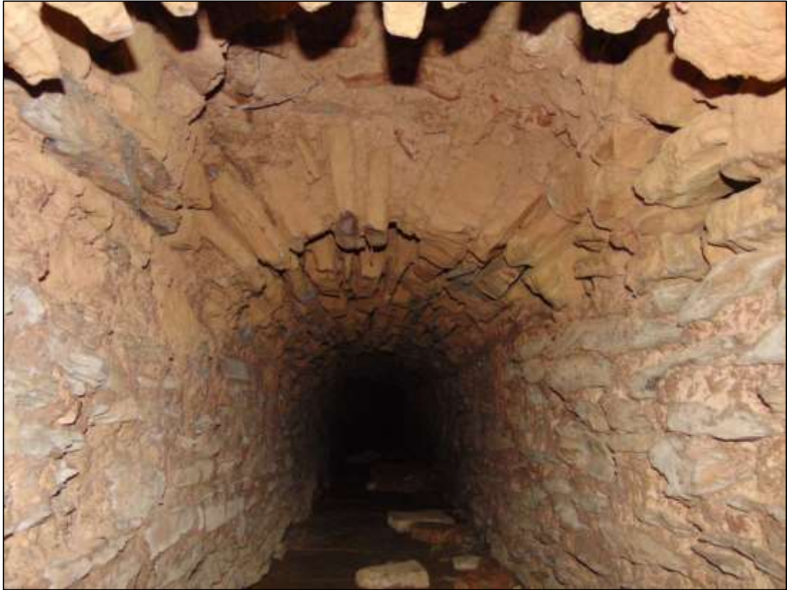
Fig. 131 - Base do sumidouro C57 visto a partir da canalização C56. Vista Sudoeste
