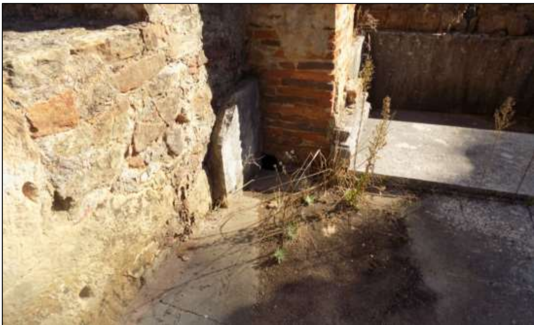
Fig. 119 - Ponto de recolha da canalização C28. Vista Este
