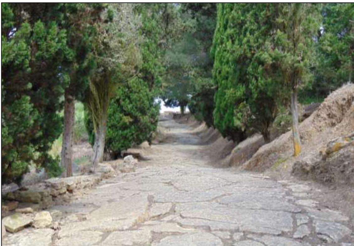
Fig. 9 - Via III, junto à confluência com as Vias VIII e IX. Vista Oeste
