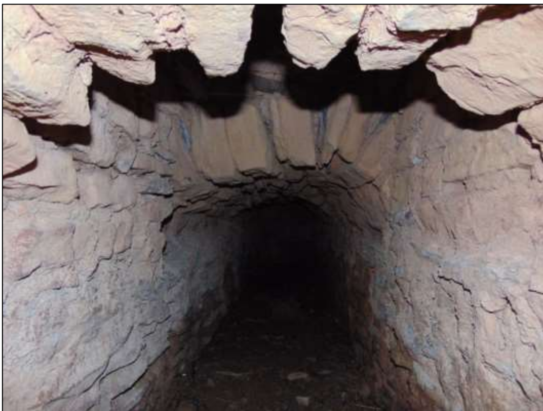
Fig. 136 - Base do sumidouro C59 visto a partir da canalização C56. Vista Sudoeste
