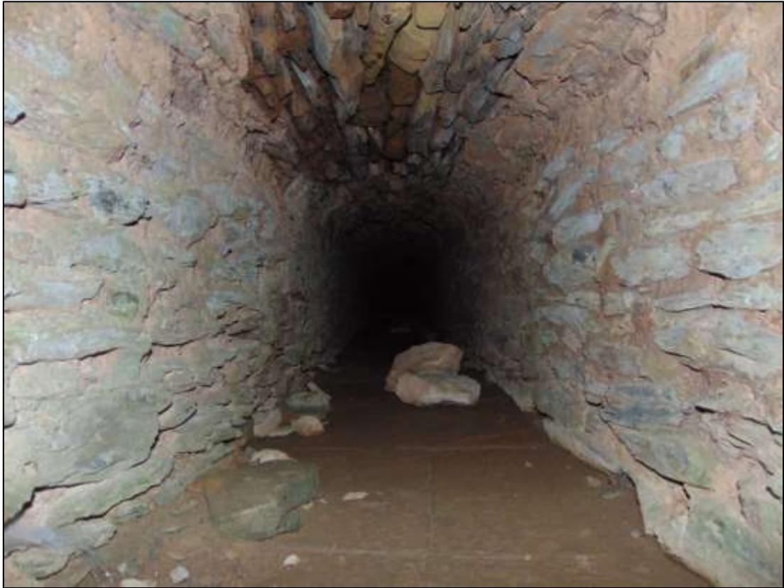
Fig. 106 - Interior da canalização C56 junto ao seu ponto de escoamento. Vista Sudoeste
