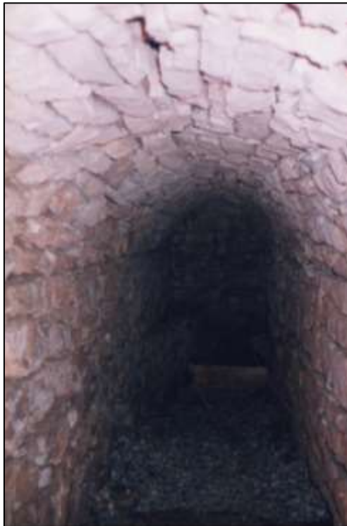
Fig. 146 - Interior da C25 durante os trabalhos de restauro de 1998 Vista Nordeste
