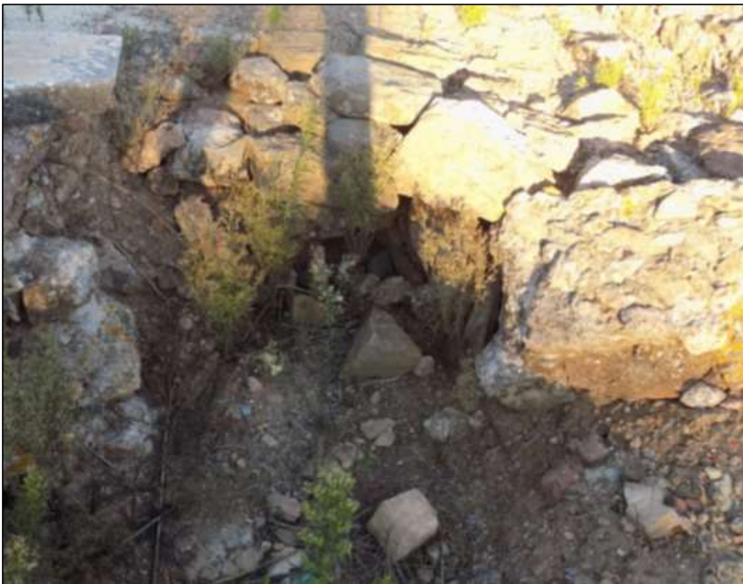
Fig. 67 - Ponto de escoamento da possível canalização C20. Vista Nordeste
