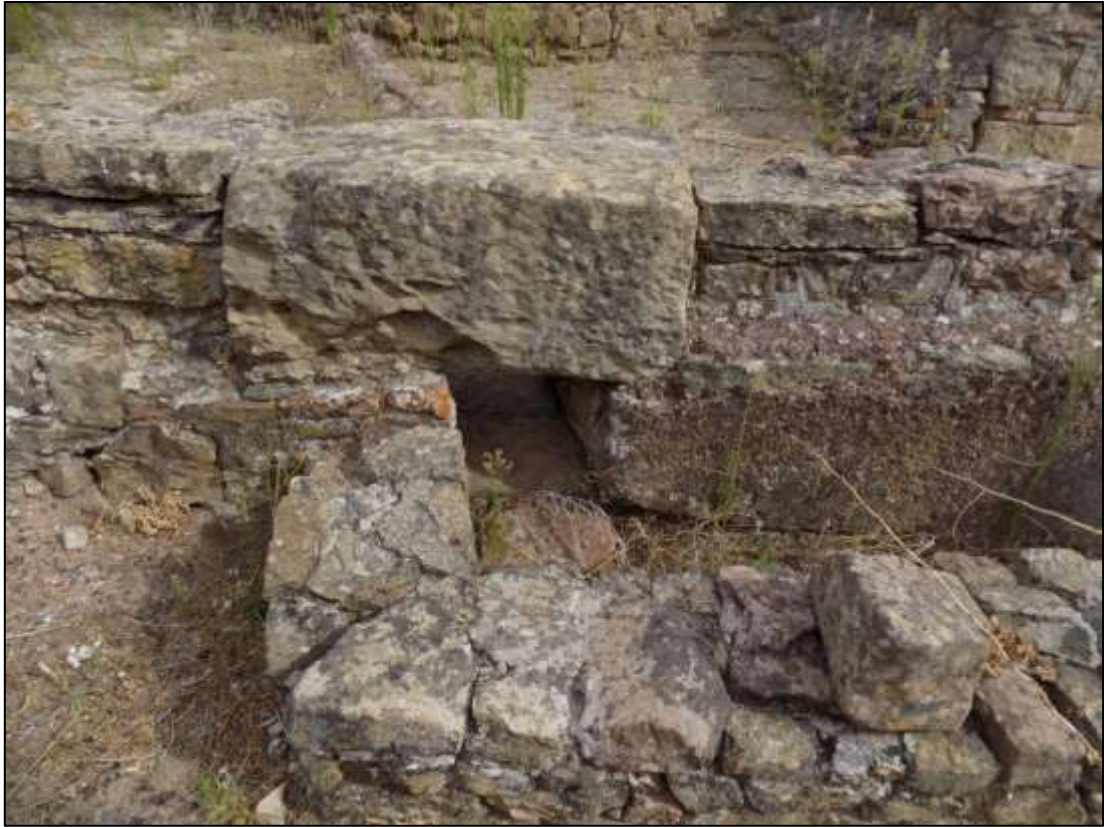
Fig. 101 - Ponto de recolha da canalização C34. Vista Norte
