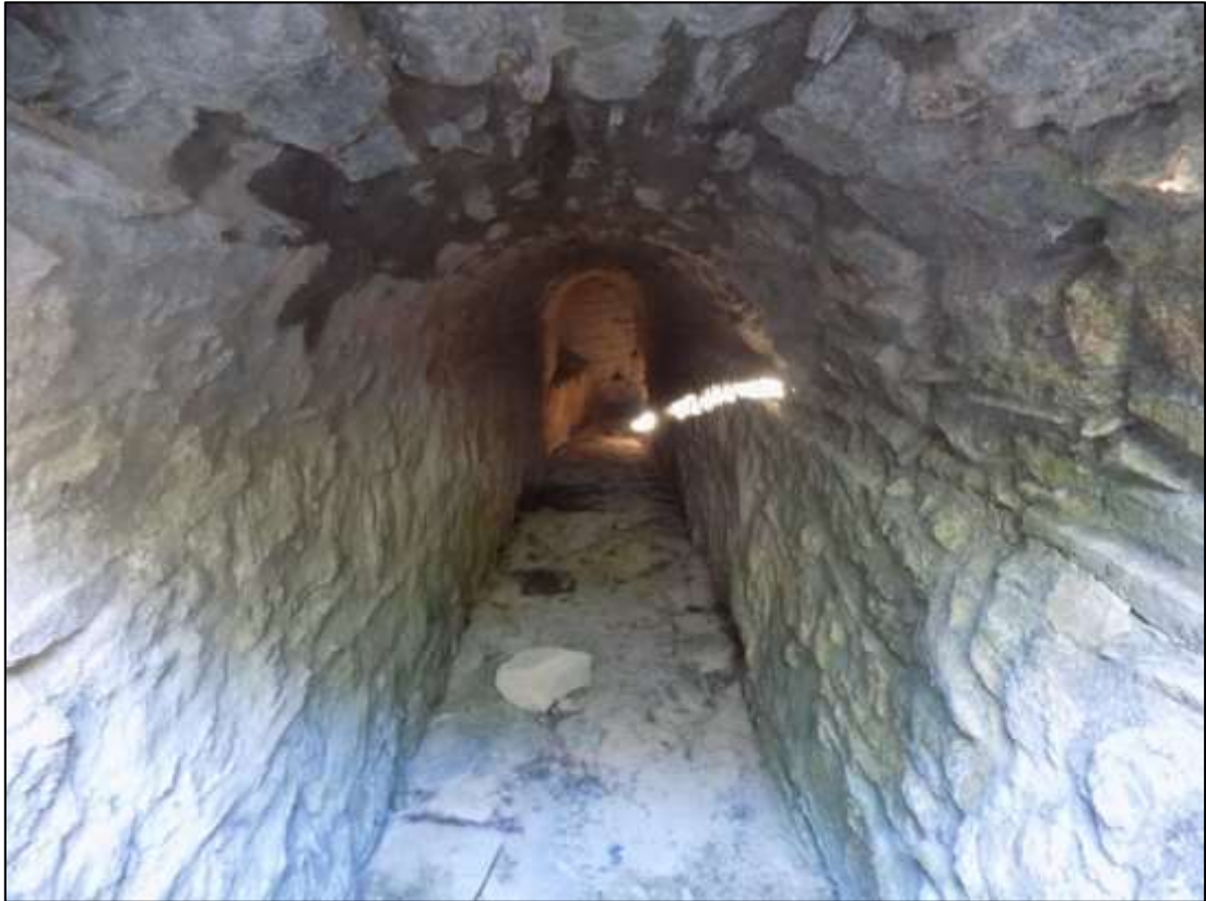
Fig. 141 - Aspecto actual do interior da canalização C25. Vista Nordeste
