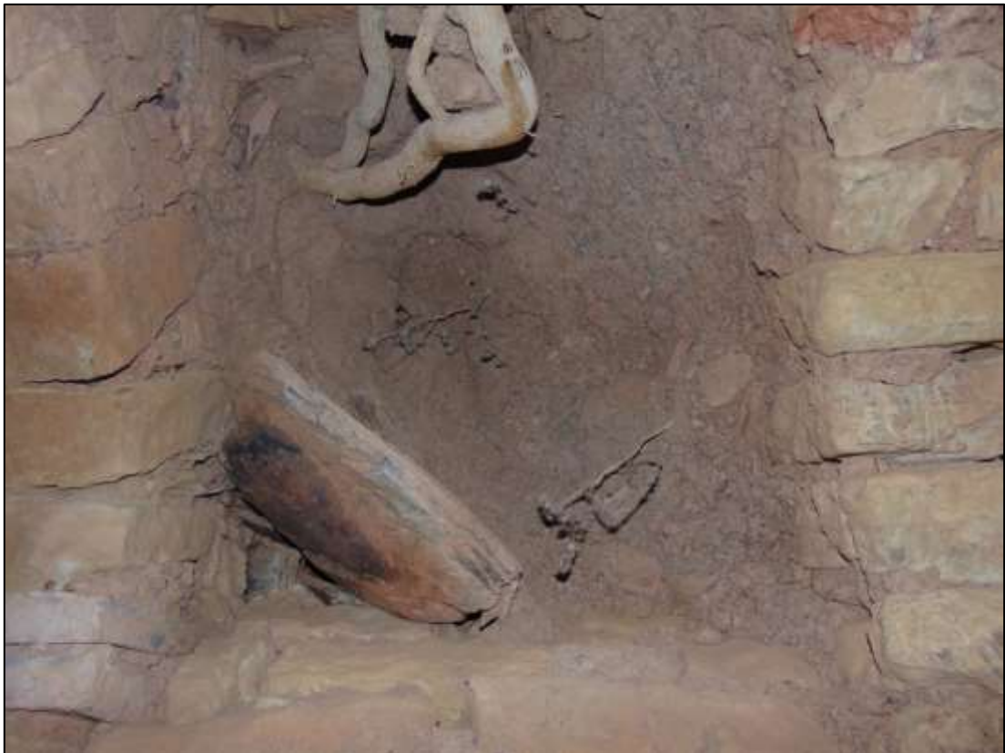
Fig. 138 - Interior do sumidouro C60, obstruído.
