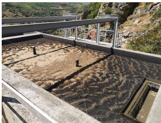
Figura 3.5 Reator biológico da ETAR de Valdigem
