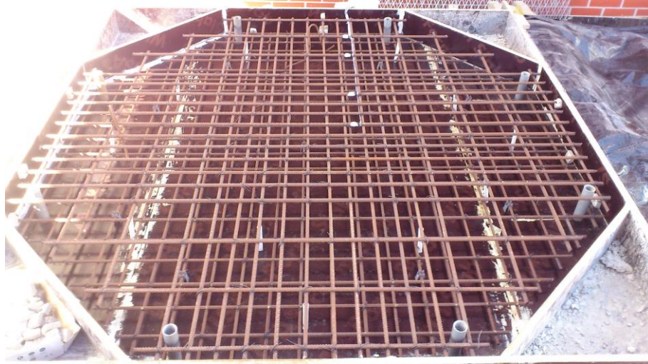
Figura 3.4- Disposição das armaduras longitudinais na cofragem do modelo de laje A
