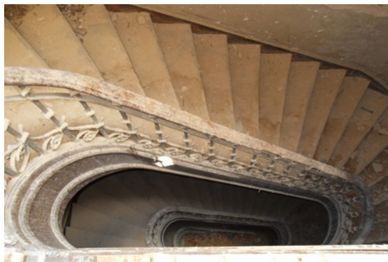
Figura 5.17 - Escadas interiores num edifício “Gaioleiro”
