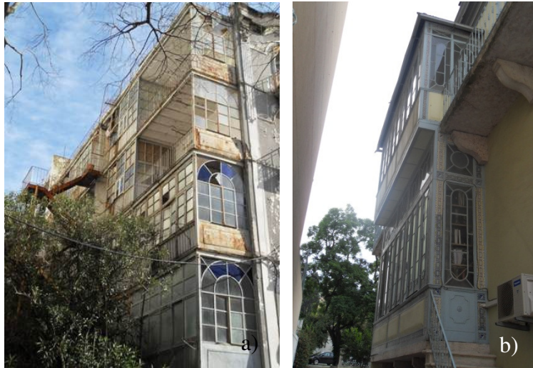
a) Tardoz de um edifício “Gaioleiro” onde se localizam as marquises
