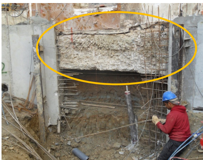
Figura 5.7 – Fundação de edifício “Gaioleiro” em reabilitação
