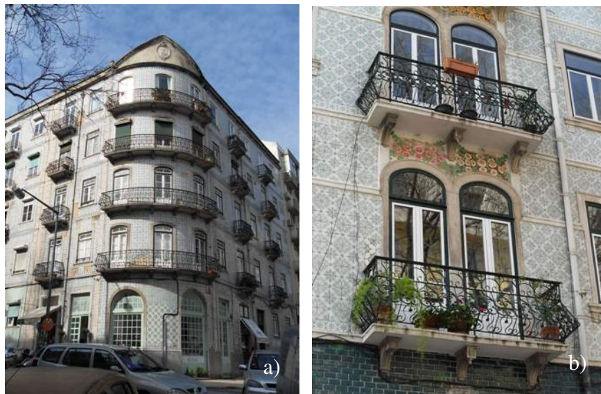
a) Edifício “Gaioleiro” com revestimento exterior em azulejo; b) Cantaria localizada na fachada principal de um edifício “Gaioleiro”
