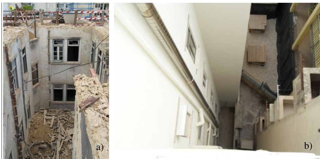
a) Saguão central de edifício “Gaioleiro” localizado na Avenida da República n.º46
