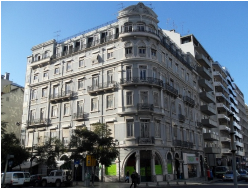
Figura 2.10 - Edifício “Gaioleiro” localizado na Av. da República, em Lisboa
