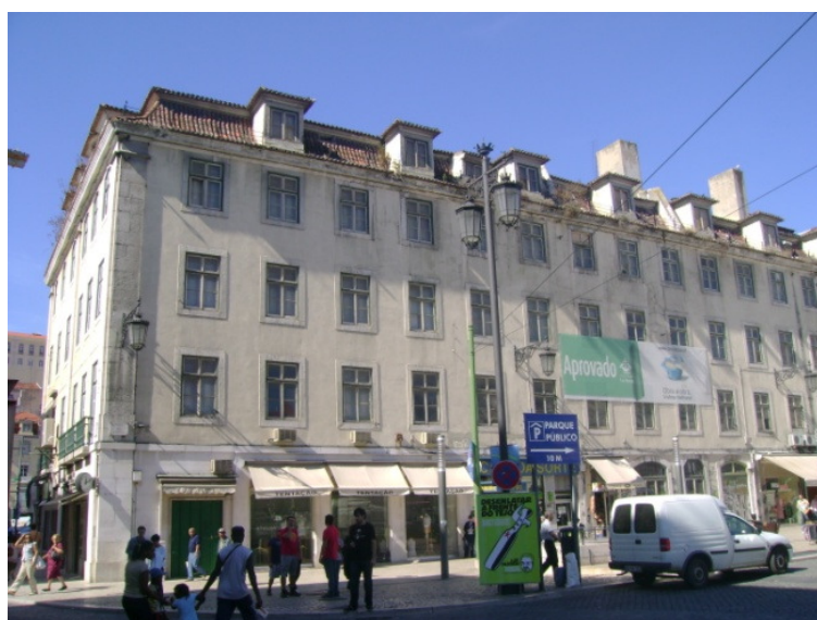
Figura 2.9 - Edifício Pombalino localizado em Lisboa
