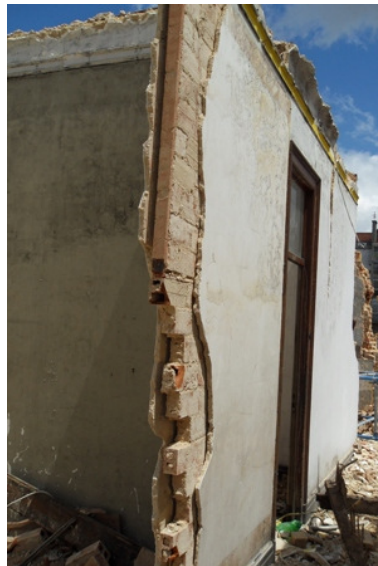
Figura 5.10 - Parede de compartimentação em tijolo maciço
