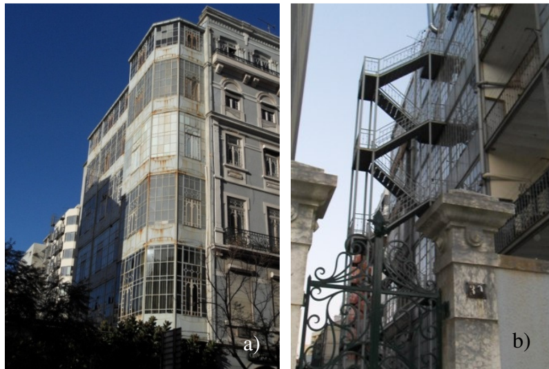
a) Marquises localizadas na fachada tardoz de um edifício “Gaioleiro”
