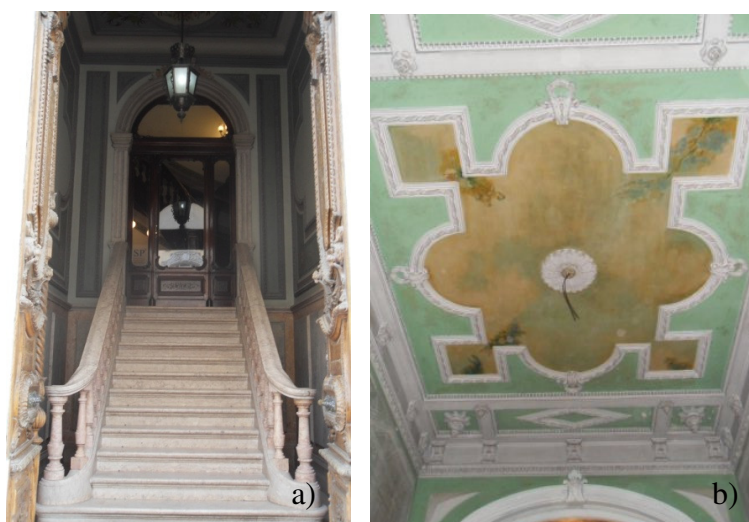
a) Atrio de entrada de edifício “Gaioleiro” com guarda-vento
