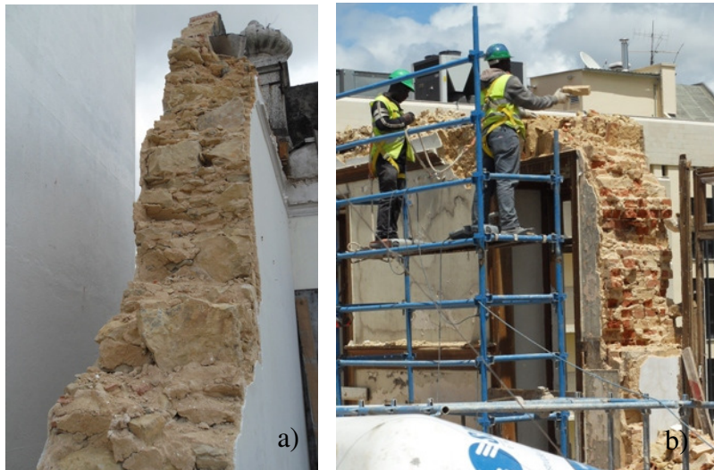
a) Parede exterior em alvenaria de pedra irregular
