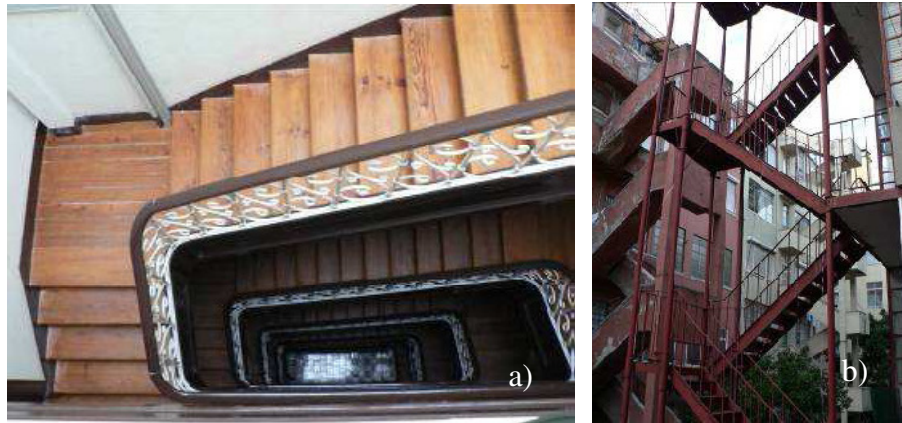
a) Escada interior em madeira; b) Escada exteriores metálicas
