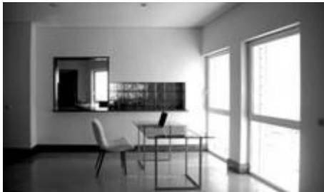
Figura 5.10. – Estores exteriores descidos para controlar a entrada de luz. ©TironeNunes
