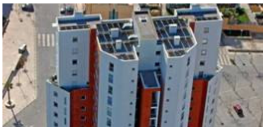
Figura 5.17. – Colectores solares distribuídos pela cobertura do edifício. ©TironeNunes
