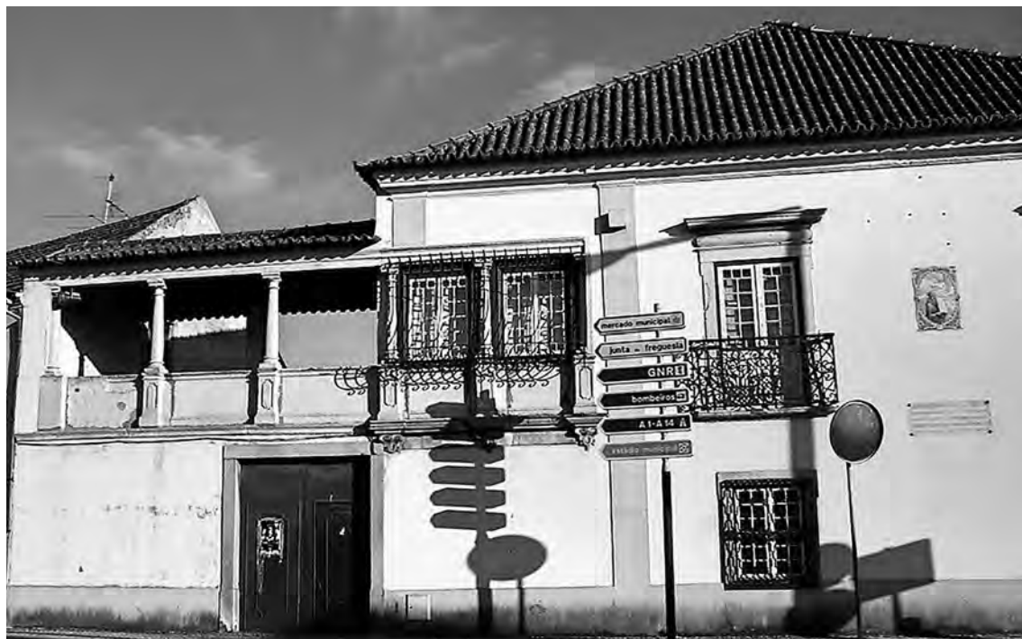
Fig. 9 – Placa alusiva da passagem de Wellesley pela casa do capitão-mor de Cantanhede, na fachada lateral norte da mesma
