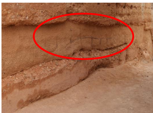
Figura 3.6 Armaduras de aço inox liso expostas após degradação em zona de terra projetada
