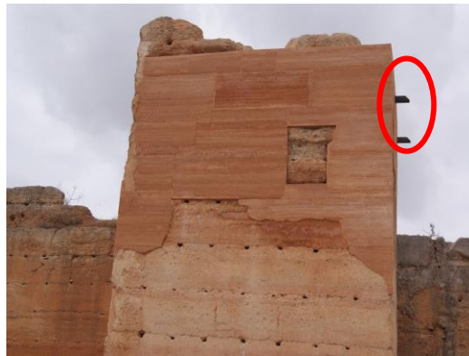
Figura 3.10 Alçado Nascente da torre observando-se a taipa antiga (em baixo) e nova (em cima) com “janela” de taipa antiga; vista das gárgulas de drenagem da cobertura na fachada Norte
