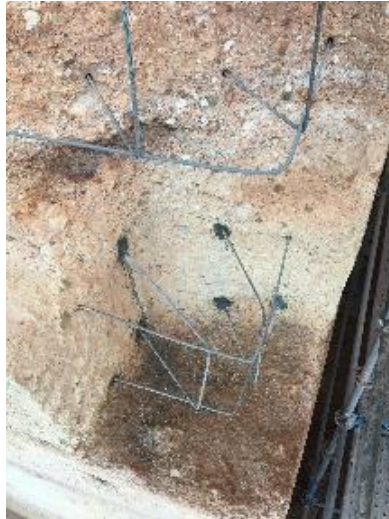
Figura 3.8 Pormenor da utilização de varões de aço inox nervurados aplicados com bucha química para reforço da taipa nova a realizar em cunhal da torre, após preparação da taipa original (Cotrim et al. 2018)
