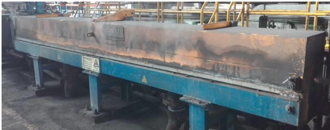
Figura 3.32- Zona de Arrefecimento Controlado
