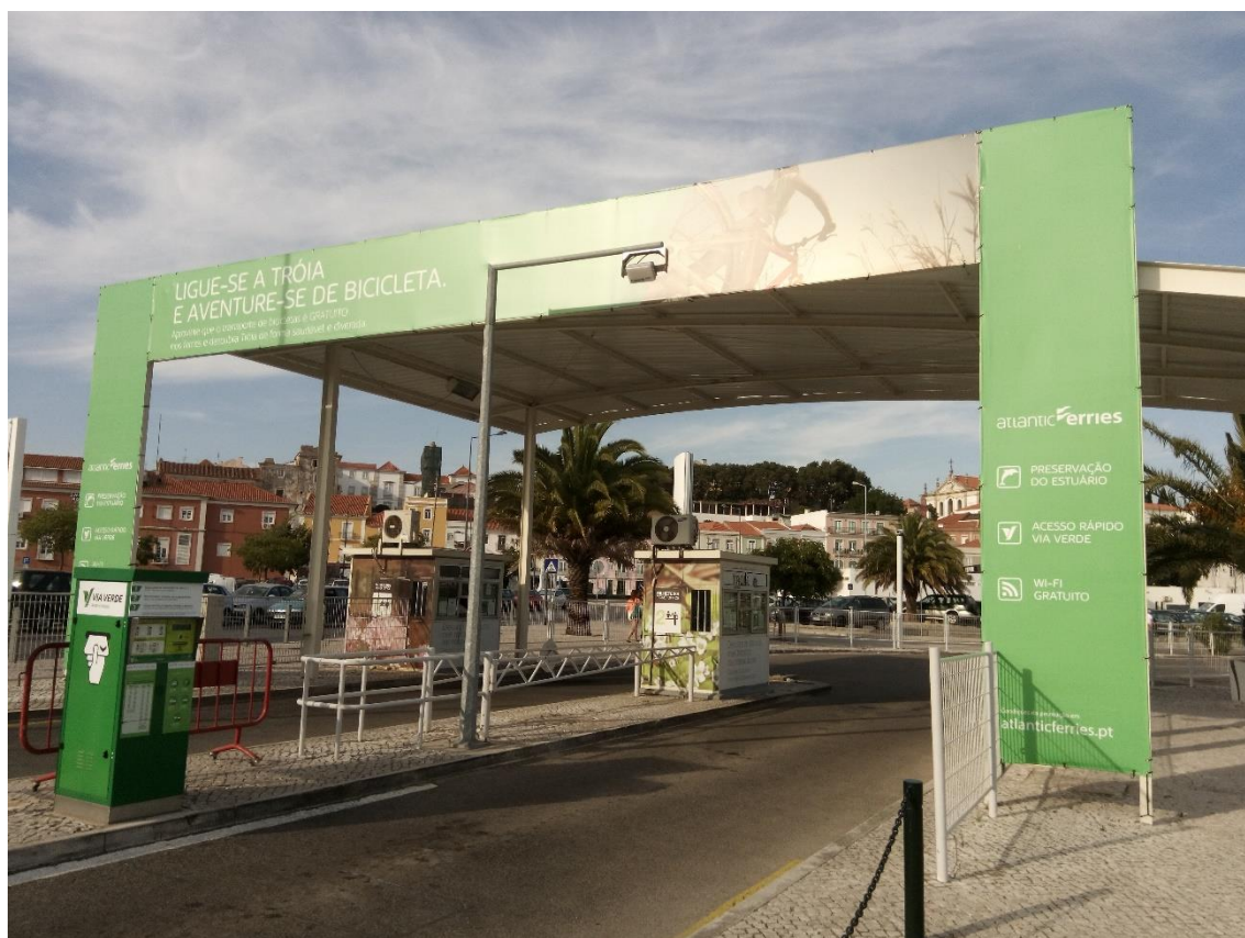
Figura 6-3: Entrada para o cais do Ferry.
