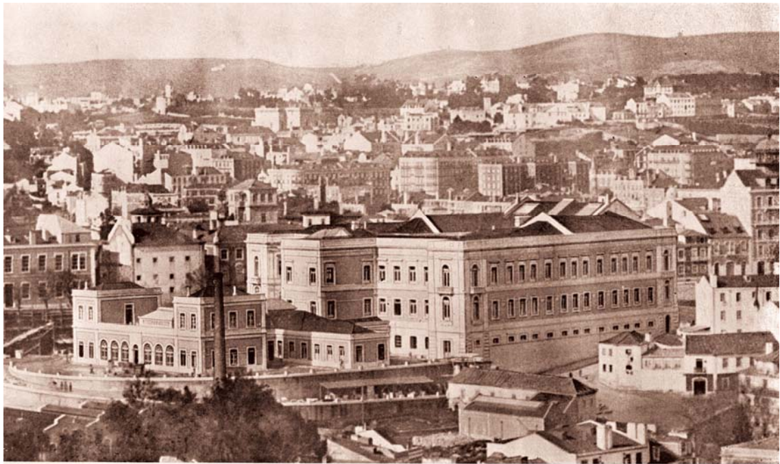
Vista geral da Nova Escola Medica de Lisboa
