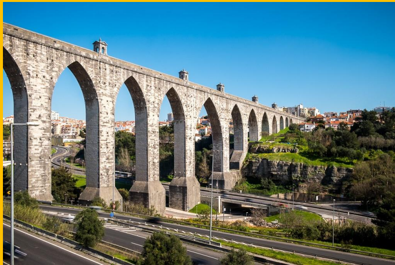
Fig. 5 – Aqueduto das Águas Livres de Lisboa
