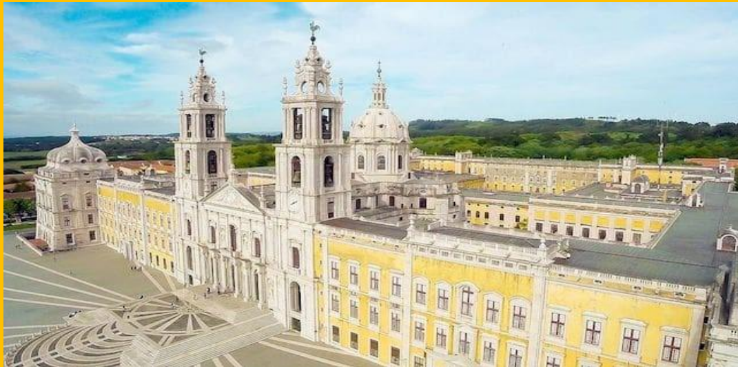
Fig. 4 – Palácio – Convento de Mafra
