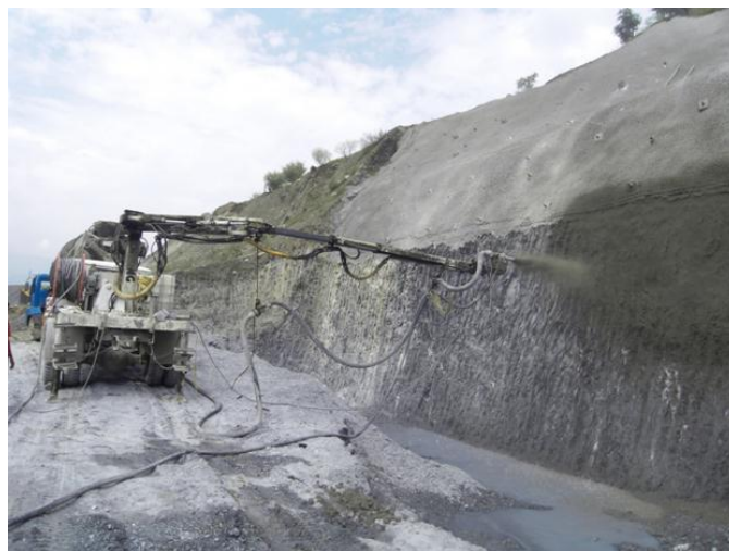
Figura 3.7 – Aplicação de betão projetado
