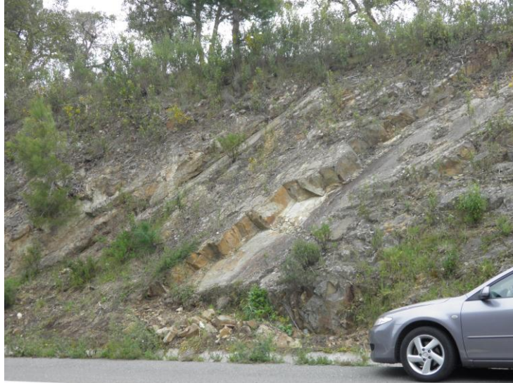
Figura 6.4 – Aspeto do talude 2
