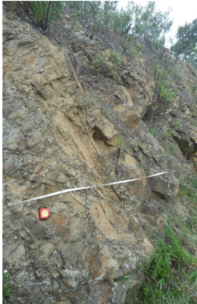
Figura 3.3 – Recurso à técnica da Scanline , num talude de escavação
