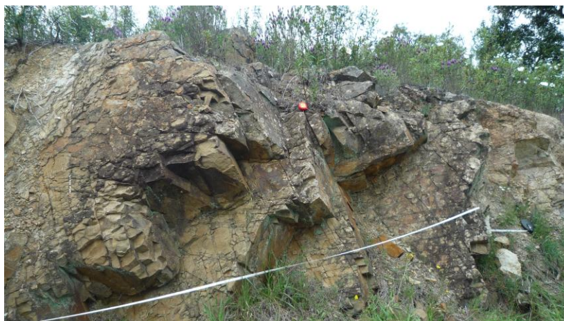
Figura 6.3 – Aspeto do Talude 1
