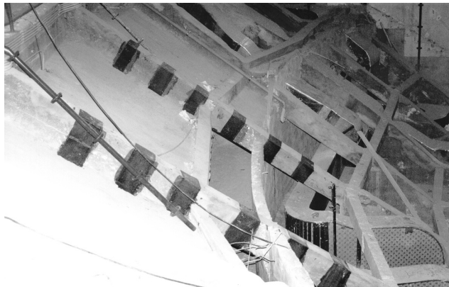
Figura 2.17: Grelha de Vigas de Betão do 2º Balcão do Teatro São Luiz
