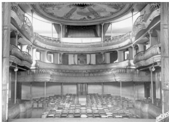
Figura 2.18: Teatro Rainha D. Amélia, em Setúbal, antes da demolição
