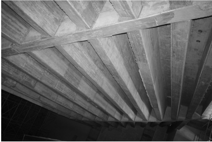
Figura 2.26: Vista Inferior do Balcão do Auditório do Hotel CS Golfe
