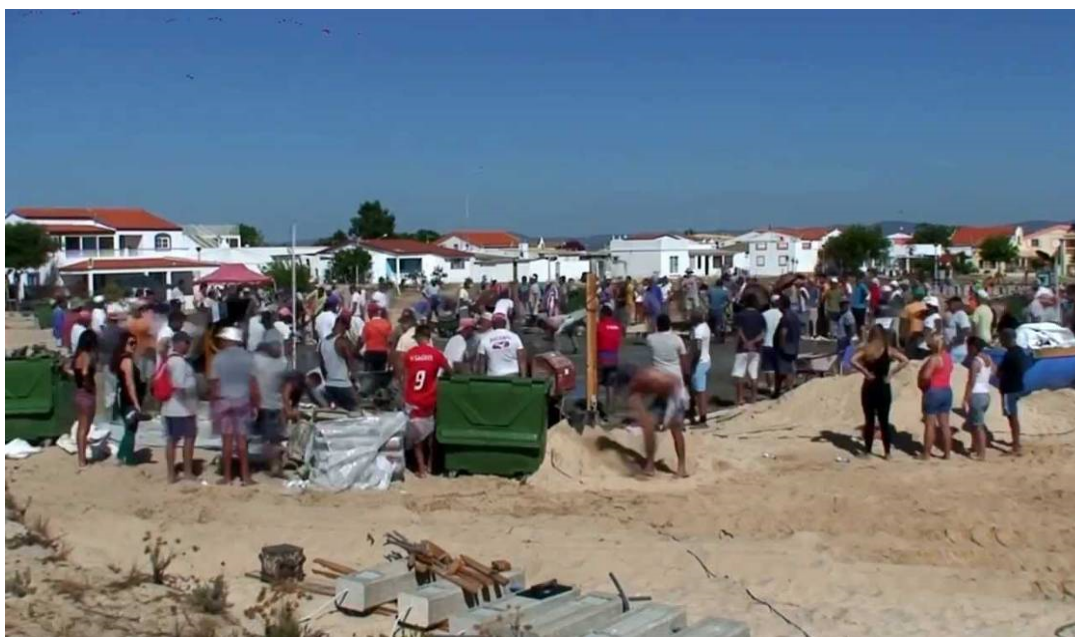
Fig. 4: Construção do denominado "heliporto" da Culatra por populares
