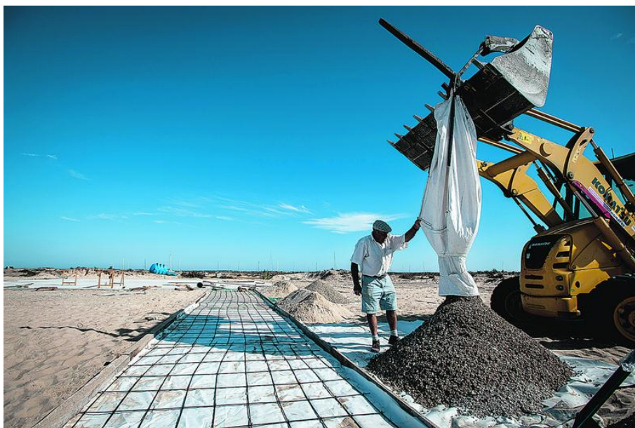
Fig. 5: Construção de acessos ao "heliporto" da Culatra.
