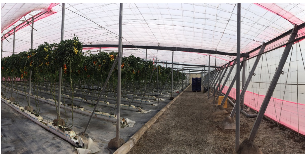
Fig. 7: Estructura de un invernadero raspa y amagado, Roquetas de Mar, Almería. E.Luque, 2018.
