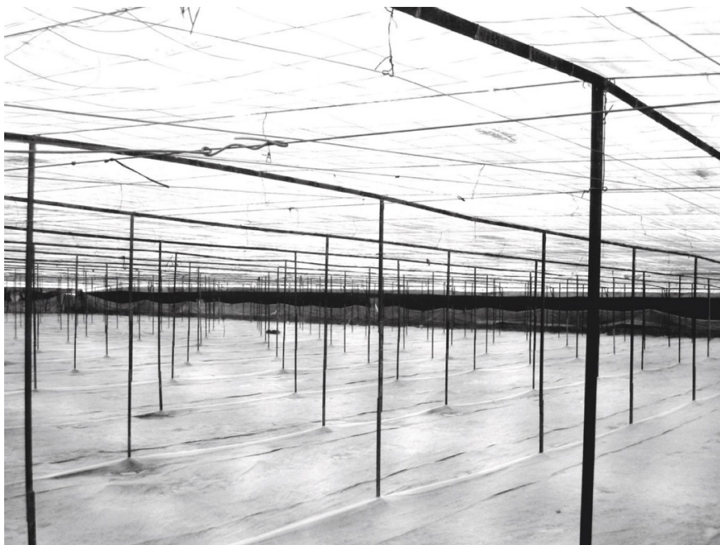
Fig. 6: Vista interior de un invernadero parral con estructura de tubos de acero, Campo de Dalías, Almería. E.Luque, 2004.
