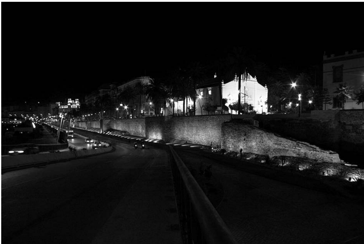
Lámina 12. Muralla del frente norte de la Ciudad.
