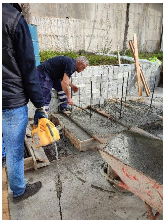
Figura 84. Vibração do maciço betonado
