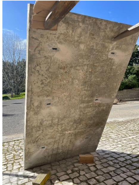
Figura 91. Tratamento da laje
