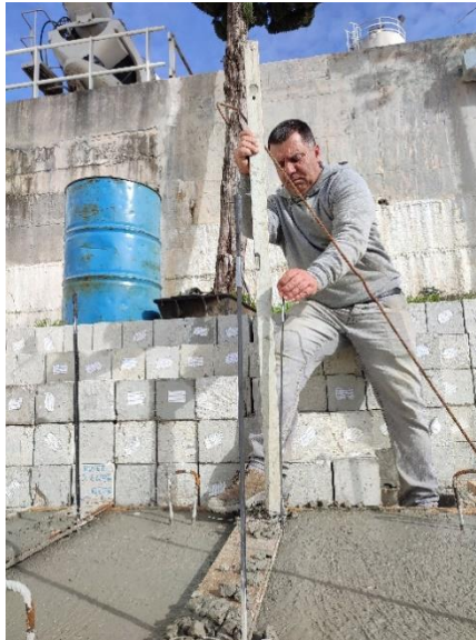
Figura 86. Ajuste da verticalidade do protótipo
