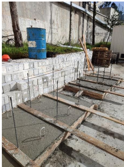
Figura 87. Disposição final dos muros
