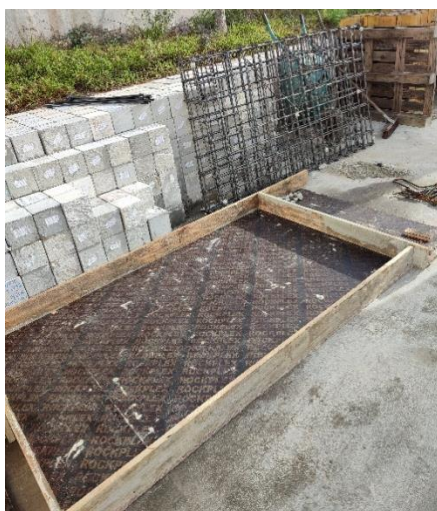
Figura 80. Cofragem lubrificada
