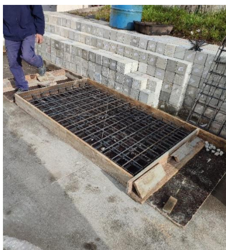
Figura 81. Aplicação da armadura com espaçadores
