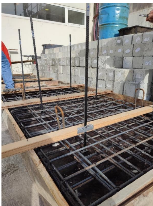
Figura 85. Fixação dos protótipos à estrutura de madeira
