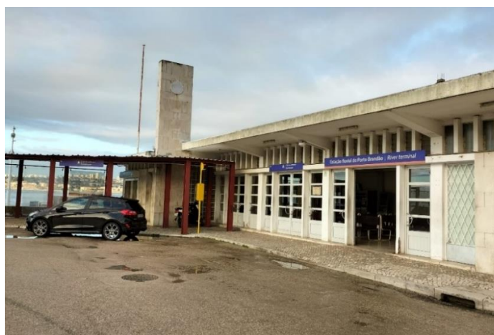
Figura 4.14 - Estação fluvial do Porto Brandão
