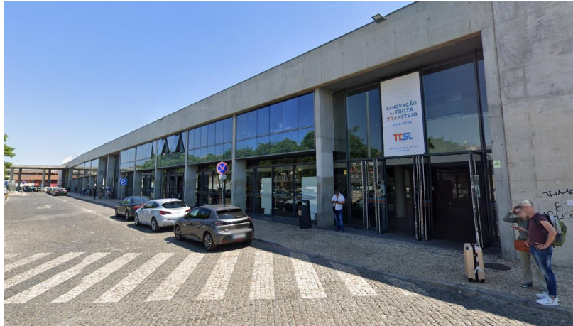
Figura 4.8 - Terminal fluvial do Cais do Sodré
