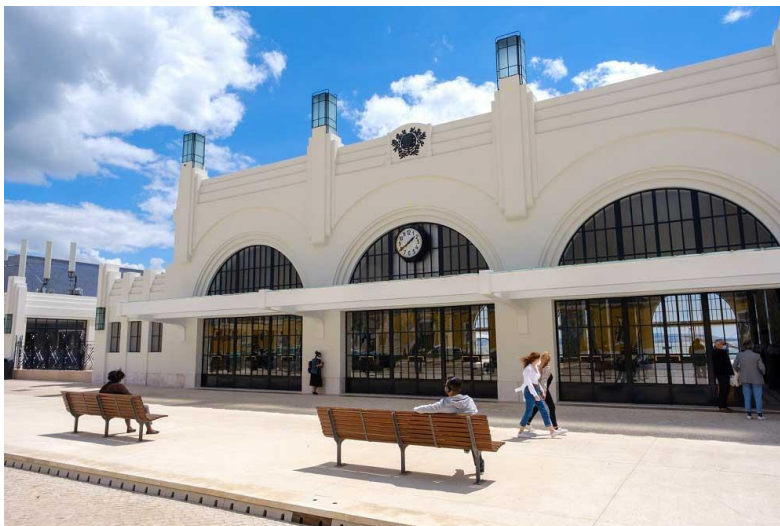
Figura 4.12 - Terminal fluvial do Terreiro do Paço Fonte: (CML, 2023a)
