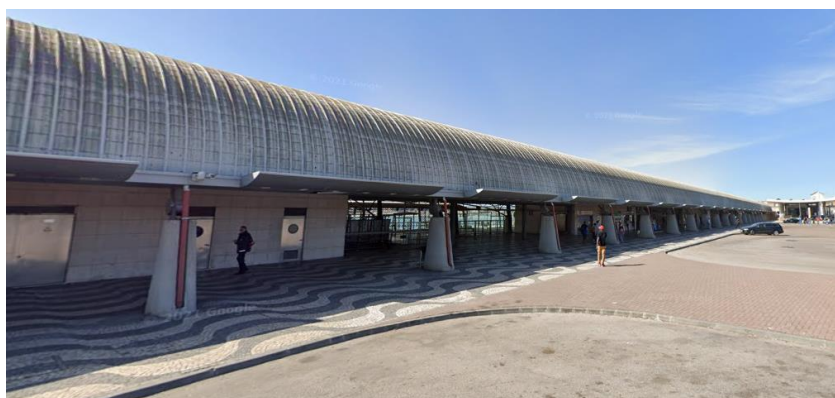
Figura 4.11 - Terminal fluvial do Barreiro
