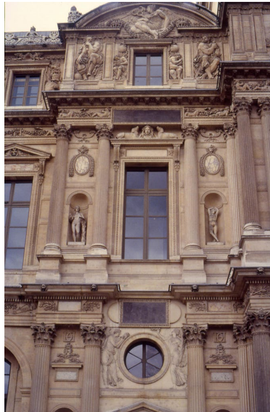
FIG. 3 Aile Lescot du palais du Louvre, Pierre Lescot, 1546-1549. Détail de l'avant-corps droit, état actuel.
