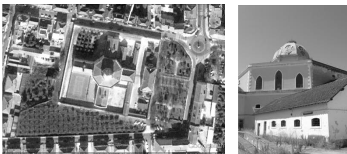
Fig. 1.20 e 1.21. Fotografia da vista área do ex-Estabelecimento Prisional de Santarém. Google Earth. Edifício da garagem e lavanderia.
