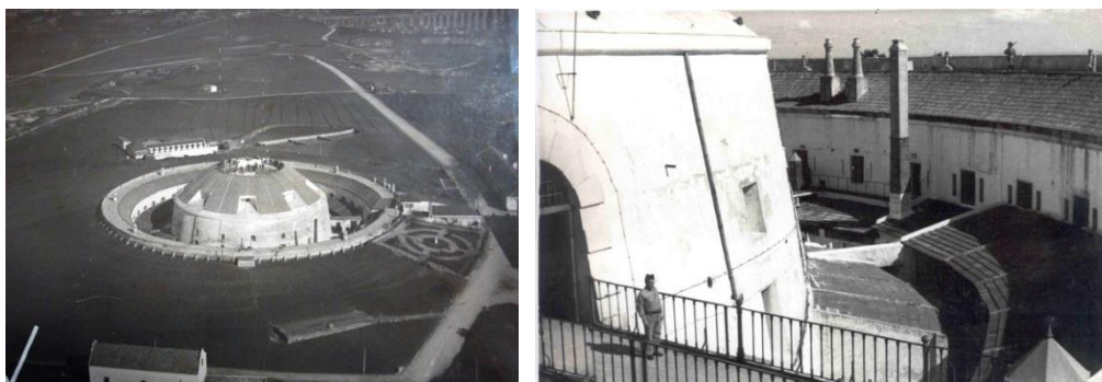
Fig. 2.10. Imagem aérea da cadeia de Monsanto inserida nos terrenos do Parque de Monsanto, em Lisboa, AHRSP. Fig. 2.11. Entrada da cadeia e vista parcial das oficinas (1945), AHRSP.
