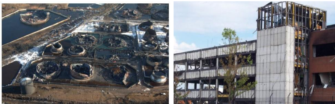
Figura 1.6 - Depósito de Buncefield após explosões (esquerda), danos num edifício próximo do local (direita), [5].
