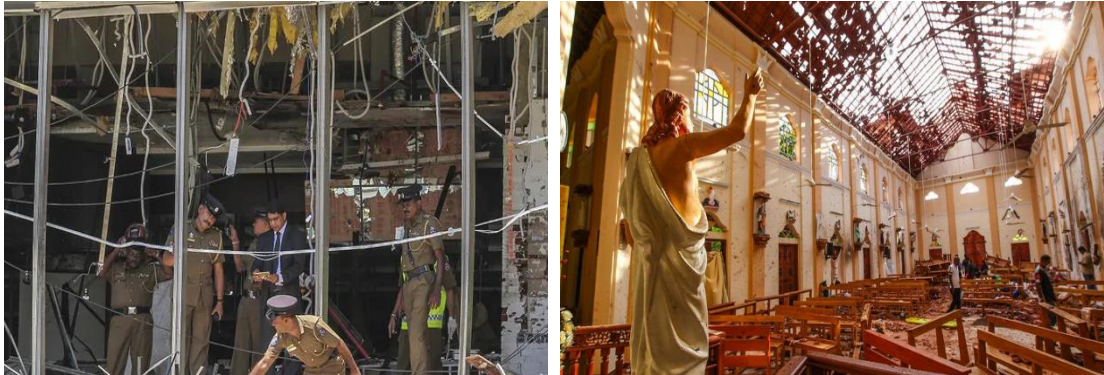
Figura 1.7 - Oficiais a inspecionarem os danos causados no hotel Shangri-La (esquerda), [7]. Danos provocados na igreja de São Sebastião, Negombo (direita), [9].
