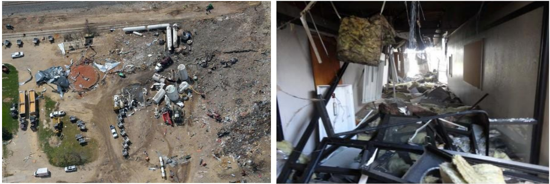
Figura 1.3 - Fábrica de fertilizantes West após explosão (esquerda), danos num edifício próximo do local (direita), [2].
