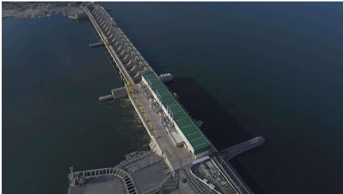
Foto: Norte Energia, sem data
