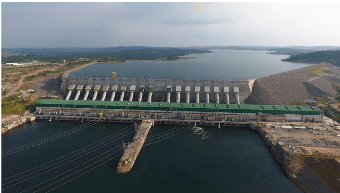
Foto: Norte Energia, sem data.
