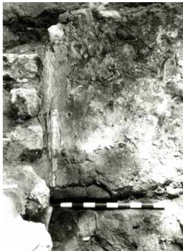
3. Pormenor da esquina interna da parede do séc. XVII/XVIII, com múltiplas camadas de cal. © Fotografia Lídia Fernandes
