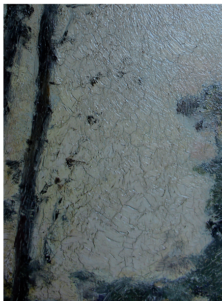
Fig. 136. Pormenor dos estalados prematuros.
