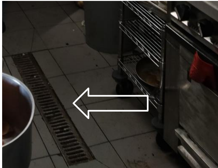
Figura 5.3 - Foto do ralo de escoamento existente no piso do estabelecimento X.
