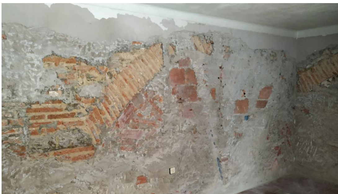
Figura 2.5 - Parede em alvenaria de pedra
