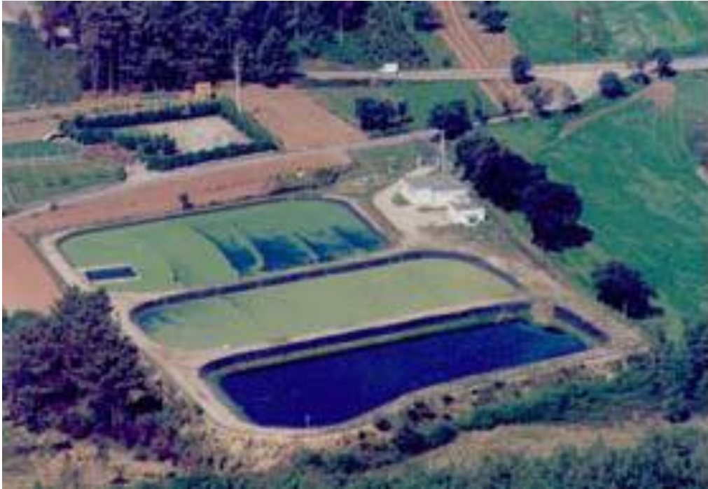
Figura 5. 3 Sistemas de tratamento por lagunagem
