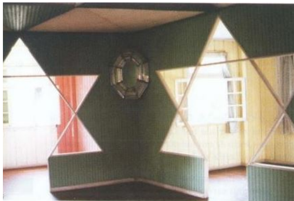
Fig. 101: Foto interna, 1ª pavimento - salas. Fonte: Key Imaguire.
