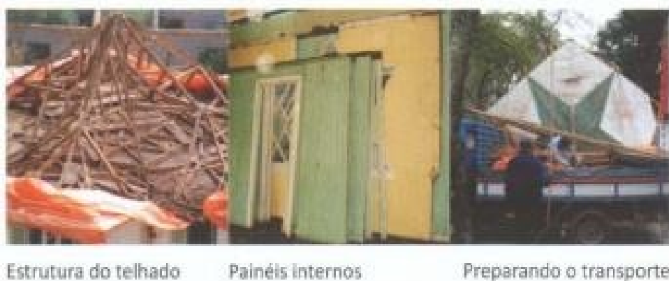
Fig. 25: Detalhes do restauro da Casa Estrela. Fonte: Livro de estudos “A Casa Estrela” – PUC-PR.
