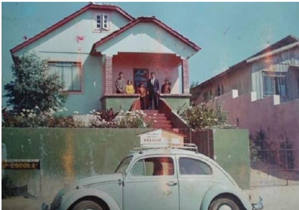
Fig. 52: Casa revestida com chapas de Erkulit. Fonte: Batista.
