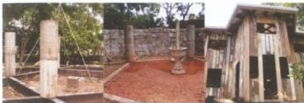
Fundação e baldrame Parede de granito A espera das janelas e porta
