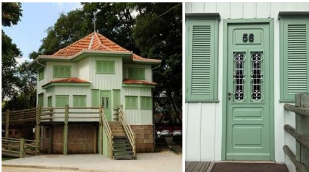
Fig.s 5 e 6 - Casa Estrela. Fonte: Autor e PUC-PR.
