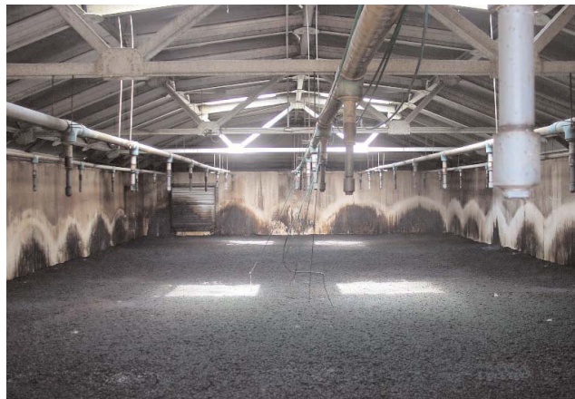
Figura 25 - Leito de enchimento de rocha vulcânica
