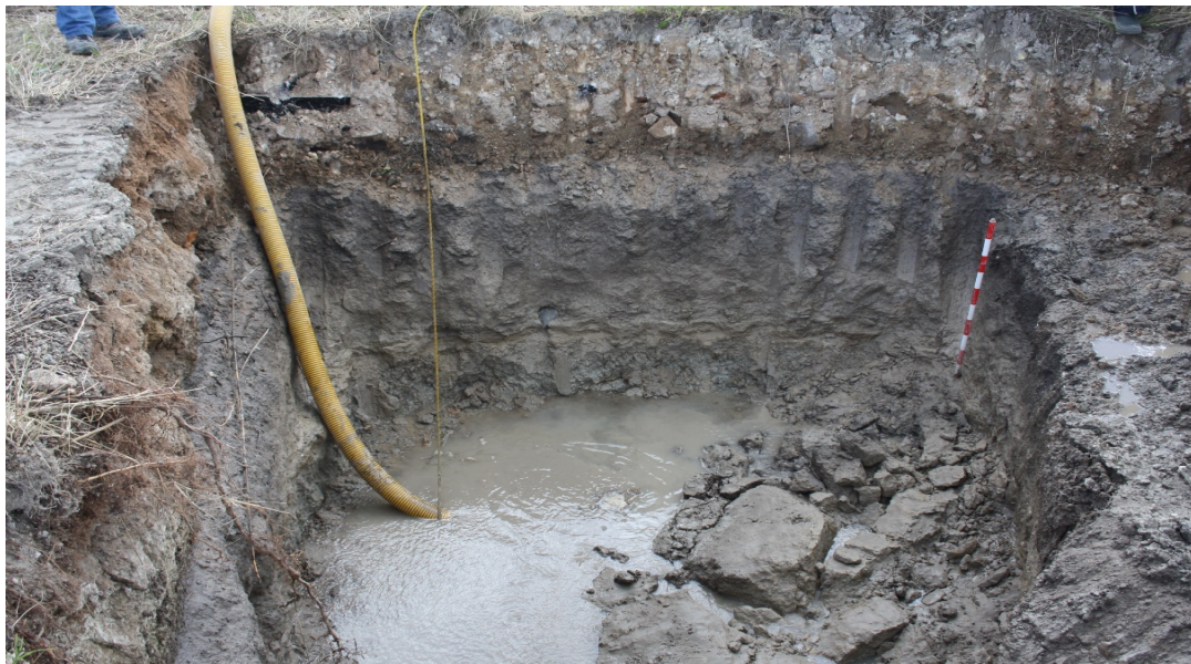
Figura 6 – Sondagem 19 – extracção de águas do nível freático com auxílio a motorbomba. Imagem cedida pelo arqueólogo responsável pela intervenção.
