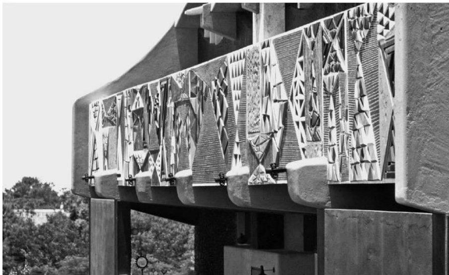
Fig. 87. Edifício O Leão que Ri, pormenor da fachada (fonte: Guedes 2009).
