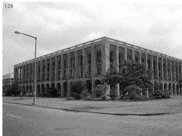
Fig. 79. Edifício dos Serviços de Fazenda, vista actual (fonte: Ferreira 2008).
