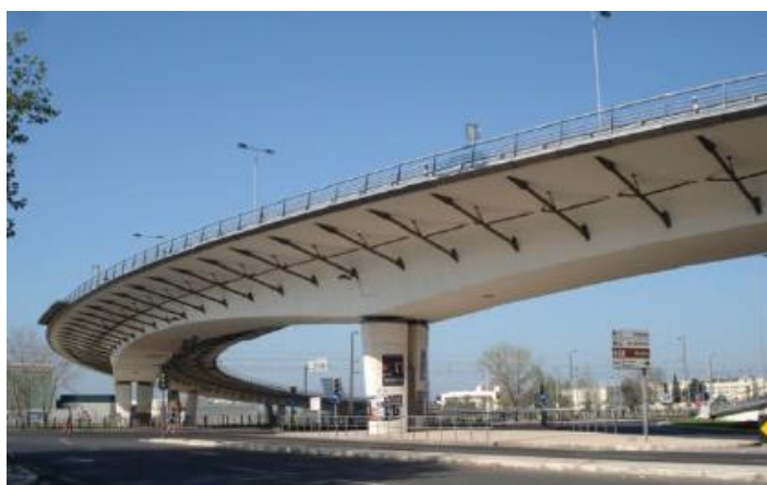
Figura 4.2- Viaduto de Algés, Oeiras (fonte: Google Maps, 2017).
