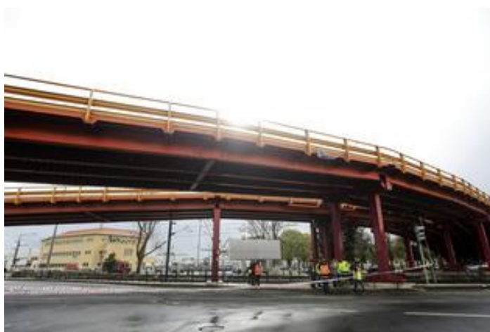
Figura 4.1- Actual ponte “provisória” de Alcântara, Lisboa (fonte: Google Maps, 2017).
