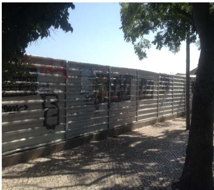
Figura 3.26- Não conformidade com o modelo TOD: Terreno abandonado, Rua da Junqueira (Julho, 2017).
