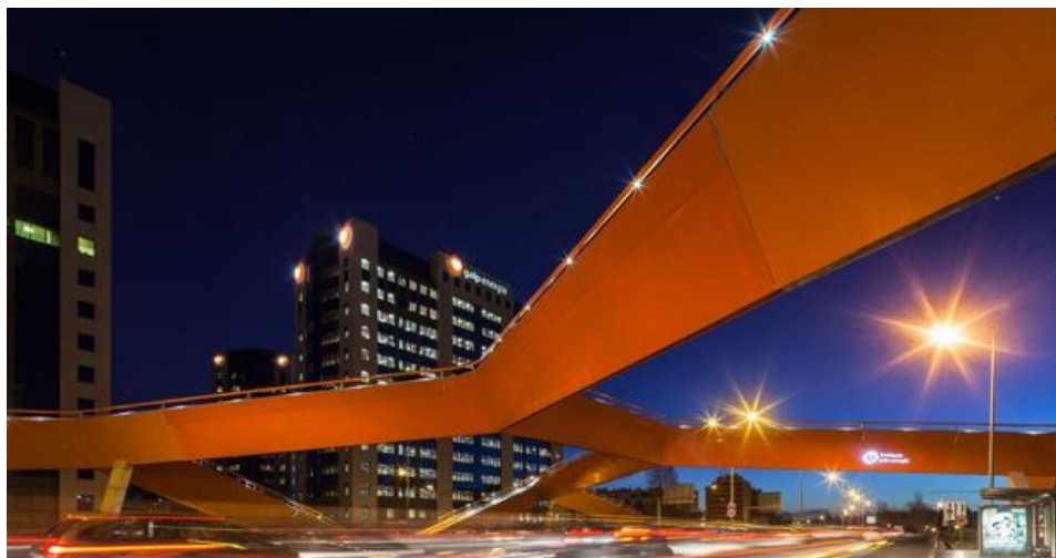
Figura 4.11- Ponte pedonal GALP, 2ª Circular em Lisboa (fonte: CML, 2016).
