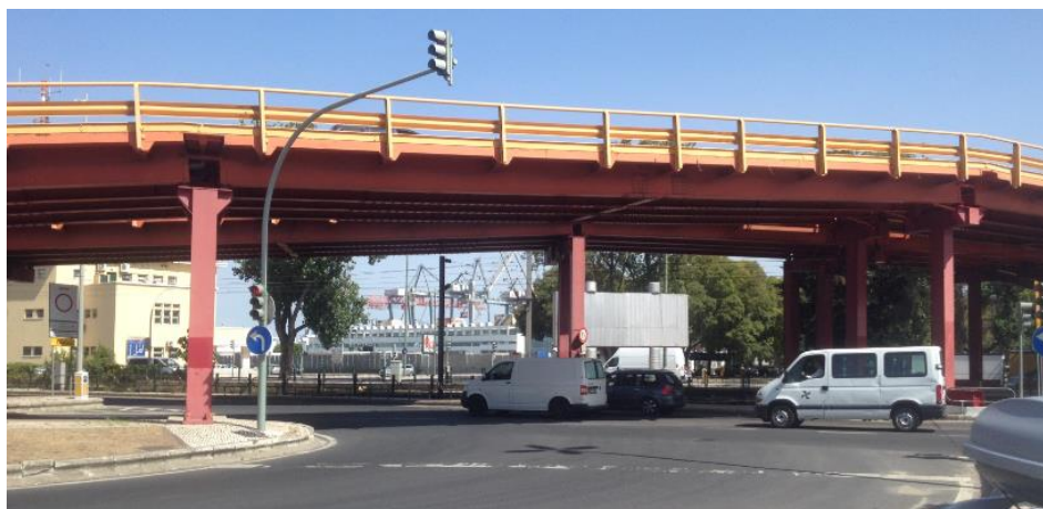
Figura 3.22- Conformidade com o modelo ABC: Avenida da Índia, Alcântara-Mar (Julho, 2017).
