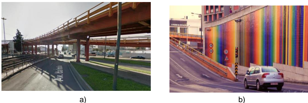
Figura 3.4- Viadutos rodoviários, Lisboa: a) Viaduto de Alcântara; b) Viaduto da Av. Infante Santo (fonte: Minube, 2017).
