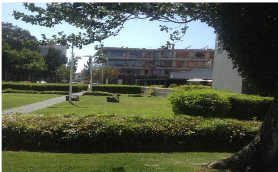
Figura 3.28- Conformidade com o modelo TOD: Jardim da Galé, Av. Índia (Julho, 2017).
