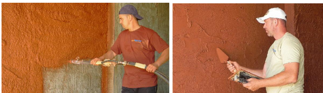
Figura 1.1 - Aplicação de camada base de reboco de terra, por projecção mecânica (a); Aplicação de camada base de reboco de terra, por projecção manual (b) (Execução: EMBARRO; Créditos: José Lima)
