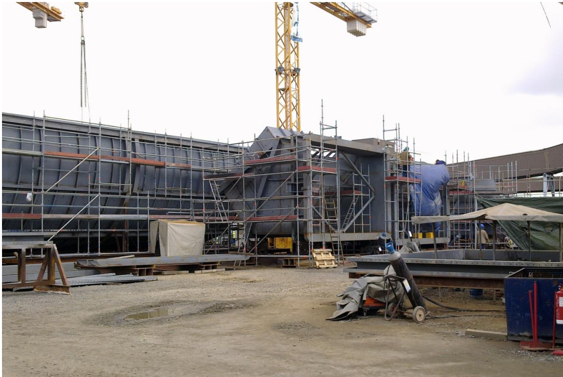
Figura 3.14 – Estaleiro de pré-fabrico da SIMI na EDP em Sines
