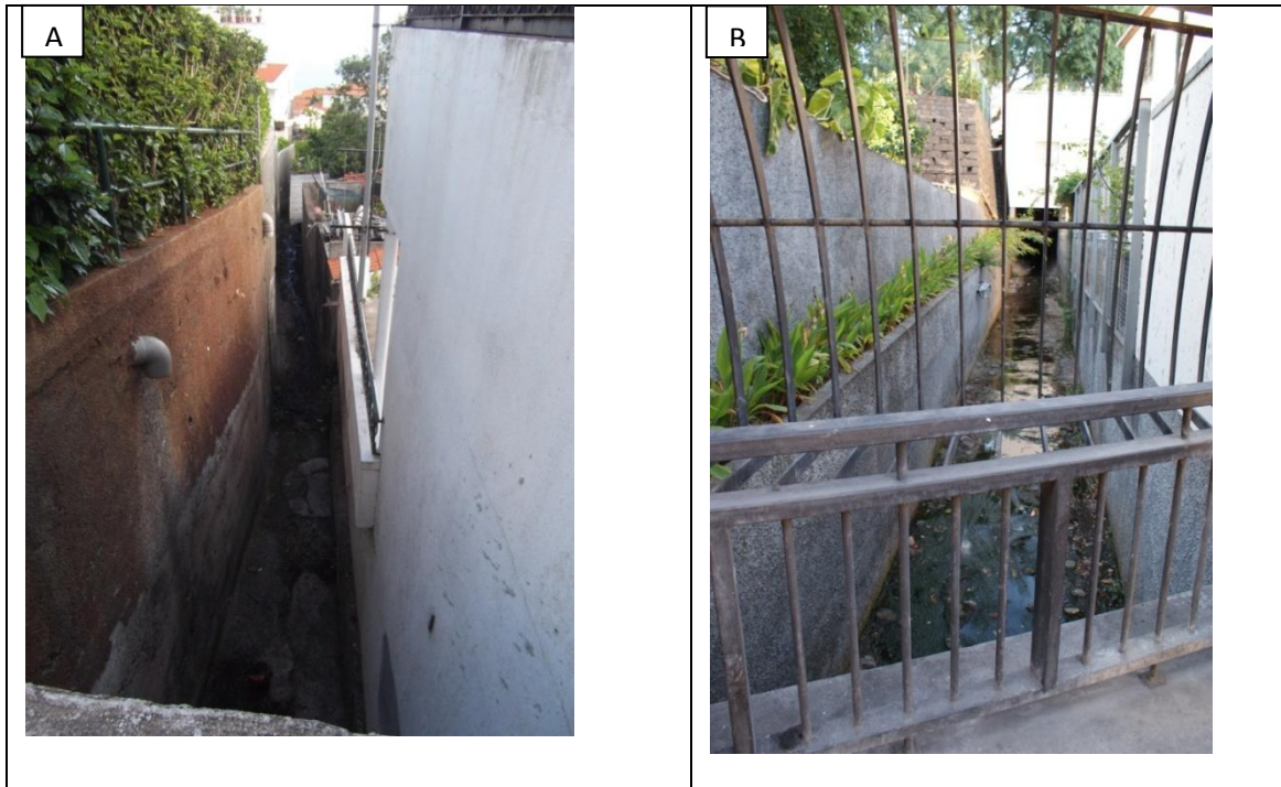
Figura 57 – Canalização do Ribeira da Nora: a 200m de altitude(A) e junto à saída sul da ESJM (B) próximo da foz.
