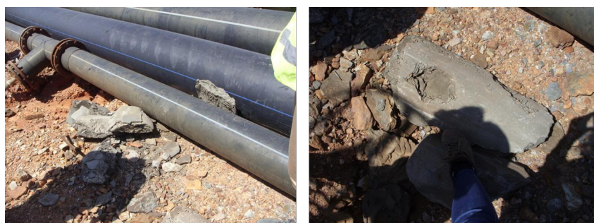
Figura 3.11: Pormenor do material que sedimentou no interior da tubagem que transporta a "polpa" até à central de pasta
