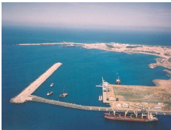
Figura 3.12. Terminal Multipurpose em 1992
