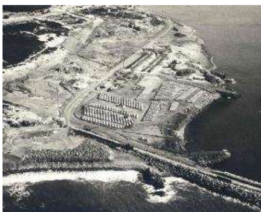
Figuras 3.6 e 3.7. Construção do Molhe Oeste em 1974
