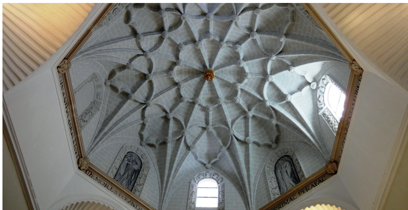
Fig. 9: Bóveda de terceletes y combados de la biblioteca del Monasterio de Piedra, construida en tiempos del abad Hernando Sancho en 1584.
