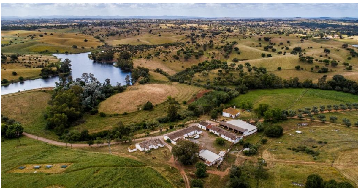
Figura 34 - Vista sobre as casas da Herdade de Vale Formoso, a barragem e os talhões do Centro Experimental de Erosão.
