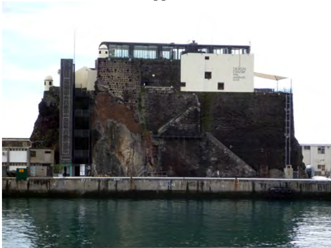
Figura 7. Forte da Pontinha ou de Nossa Senhora da Conceição. Na imagem percebe-se como a estrutura do forte foi assente em cima do afloramento rochoso. Funchal. Foto Ana Catarina Garcia.
