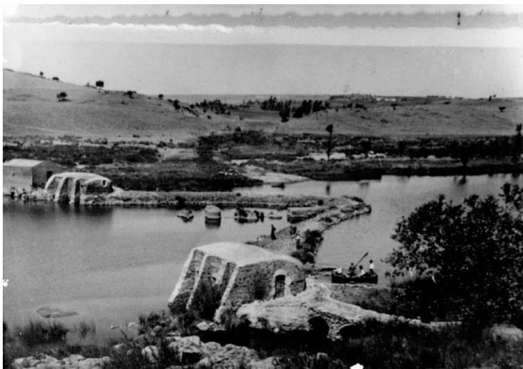
Foto 12. Azenha do Farrobo (Serpa) e Azenhas de Fagundes (Beja) no Guadiana, com as ruínas do caneiro ao meio do açude e o moleiro no seu barco com alguns fregueses. Anos 1930-1950 . Autor desconhecido. Cortesia de Francisco Manuel Aleixo, antigo moleiro (Serpa).
