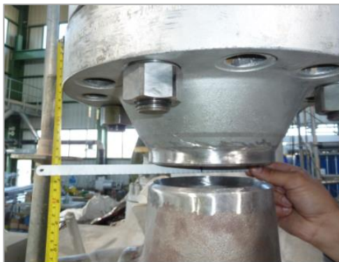
Figura 2.4 - Preparação de juntas de soldadura em aço de liga 13CrMO4
