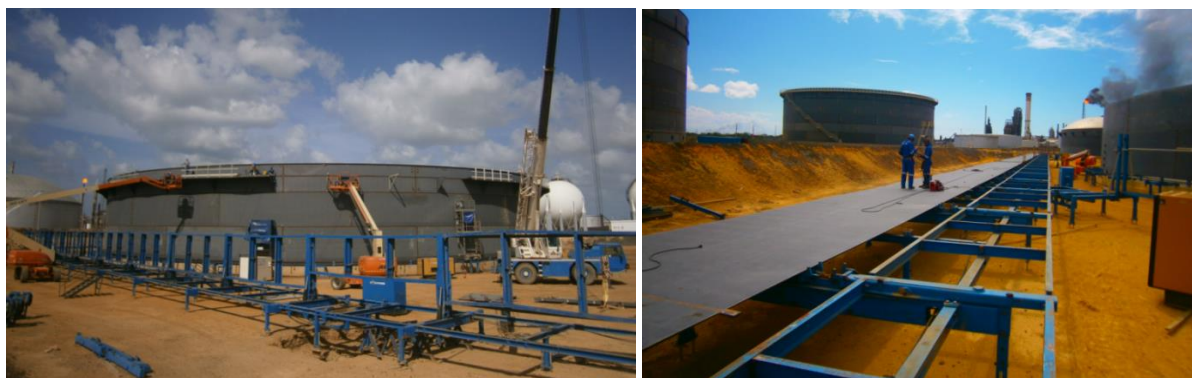
Figura 2.16 - Plataforma hidráulica para união de chapas e formação de virola
