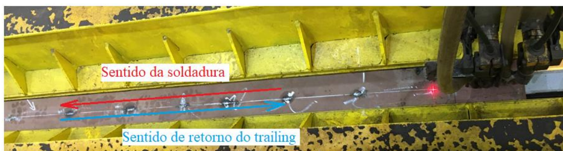
Figura 4.10 - Sentido da soldadura e posterior retorno do trailing à posição inicial
