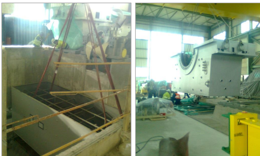
Figura 2.6 - Montagem de peça de transição (à esquerda) e casing inferior da turbina (à direita)
