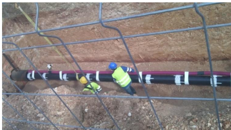
Figura 2.14 - Inserção de tubagem sob auto-estrada
