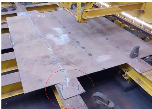
Figura 4.7 - Montagem de chapas de arranque
