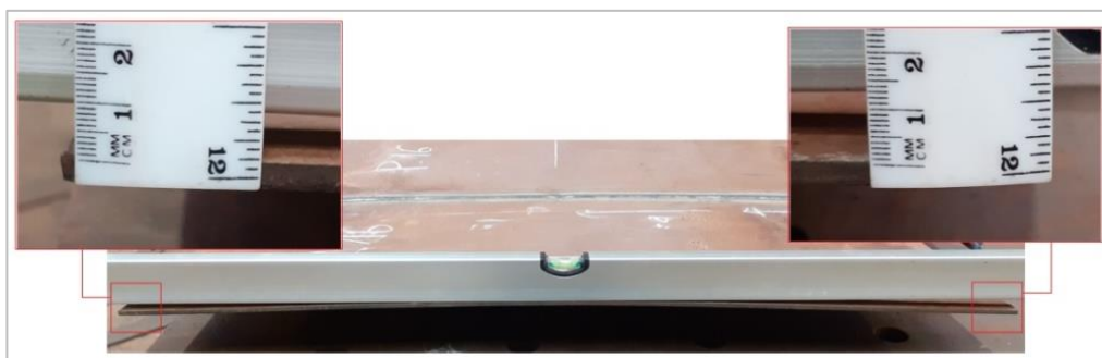
Figura 4.61 - Deformação por encurvadura (na longitudinal) do P.16
