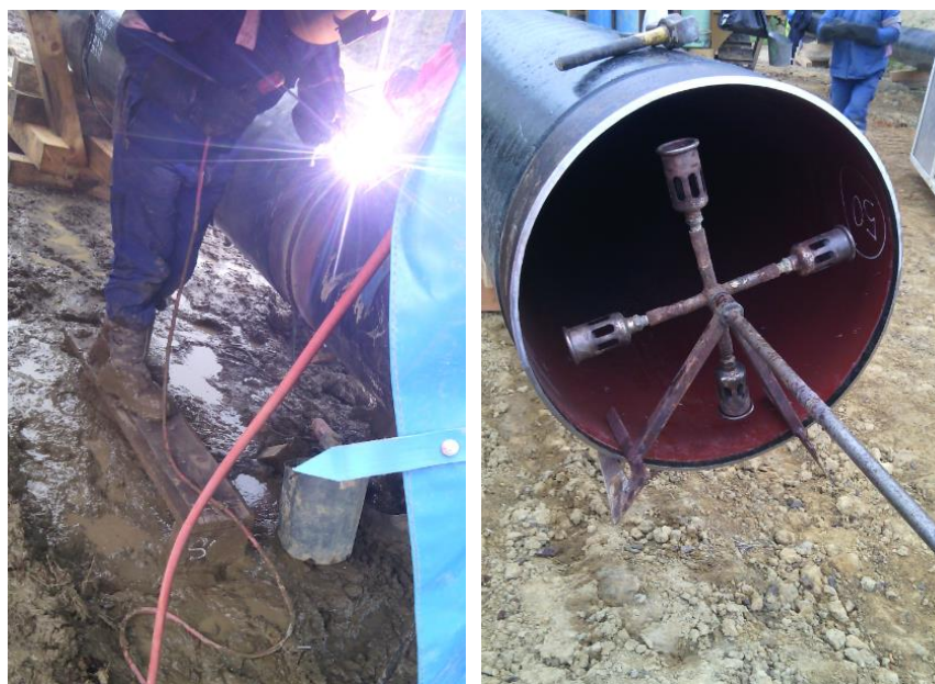
Figura 2.15 - Soldadura de tubagens (à esquerda) e maçarico rotativo de pré-aquecimento (à direita)
