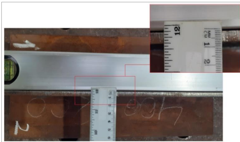
Figura 4.38 - Deformação por encurvadura da chapa menor (na longitudinal) do P.7
