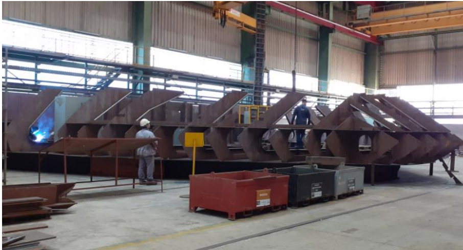
Figura 3.74 - Execução de soldaduras ao baixo (Fonte: West-sea)
