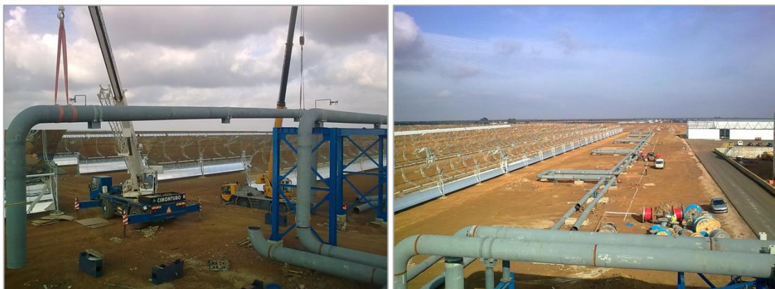
Figura 2.8 - Montagem de tubagens no campo solar
