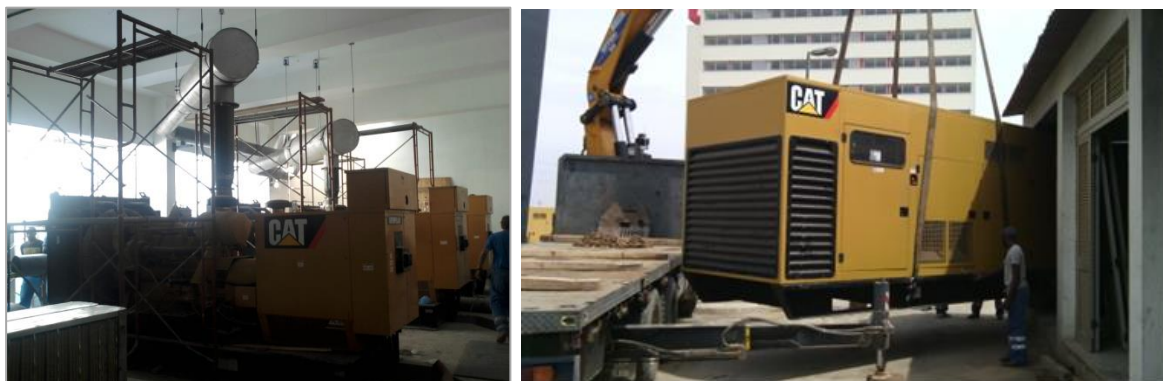
Figura 2.12 - Instalação de grupos geradores em zonas de difícil acesso
