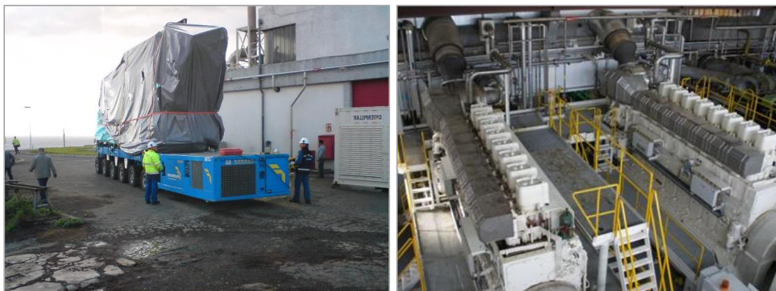
Figura 2.2 - Transporte de grupo gerador (à esquerda) e grupos geradores montados (à direita)
