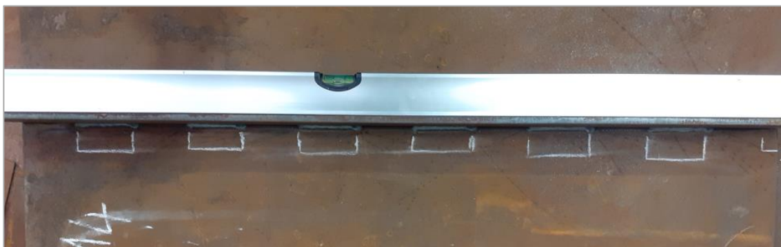
Figura 4.32 - Sem deformação por encurvadura da barra (na longitudinal) do P.14
