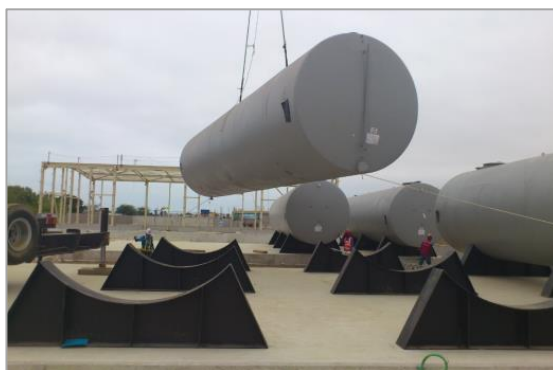
Figura 2.10 - Montagem de tanques de armazenamento de combustível
