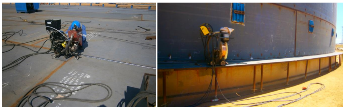
Figura 2.19 - Soldadura da base do tanque a arco submerso (à esquerda) e soldadura externa perimetral da união da base com a virola (à direita)
