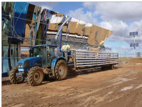
Figura 2.9 - Montagem de tubos HCE em campo
