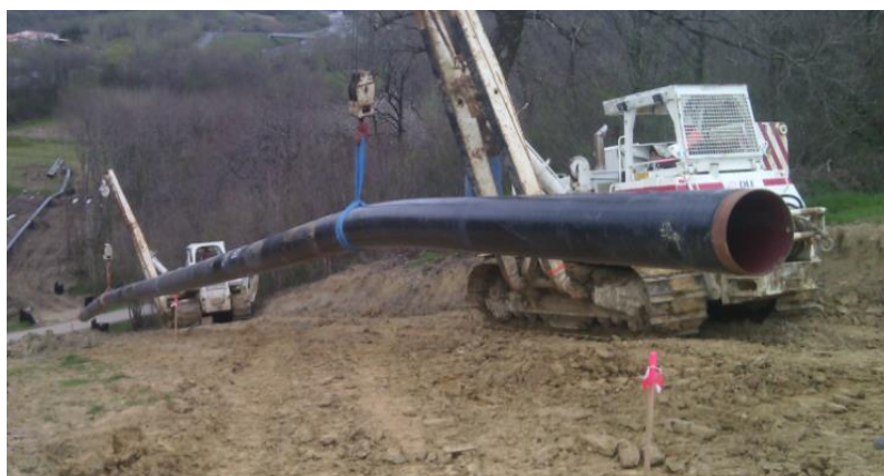
Figura 2.13 - Colocação de tubagens em vala através de sidebooms
