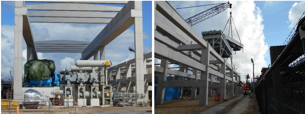
Figura 2.22 - Montagem de compressores IHI (à esquerda) e aerorefrigeradores (à direita)
