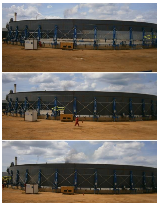
Figura 2.17 - Sequência de entrada de virolas. Primeira virola suspensa pelos elevadores e entrada de segunda virola
