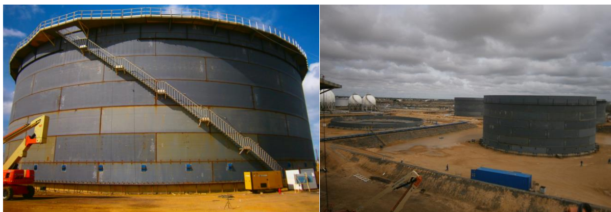
Figura 2.20 - Tanque estruturalmente concluído (à esquerda) e parque de tanques em construção (à direita)
