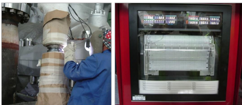
Figura 2.5 - Soldadura de aço de liga P91 com controlo de temperatura e tratamento térmico
