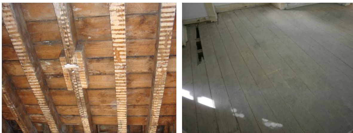
Fig. 2.21 – Pavimento em soalho constituído por pranchas de madeira
