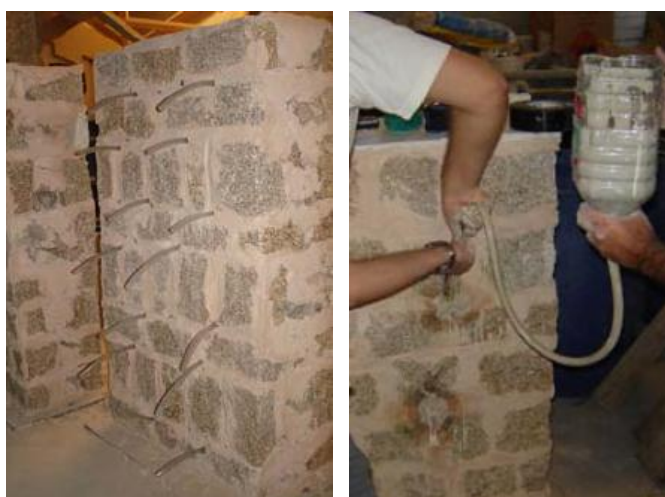
Fig. 4.12 – Exemplo de injeção de calda por gravidade
