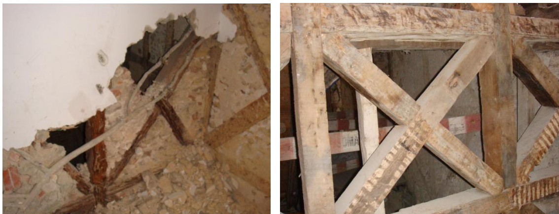
Fig. 5.23 – Reconstrução de parede de frontal
