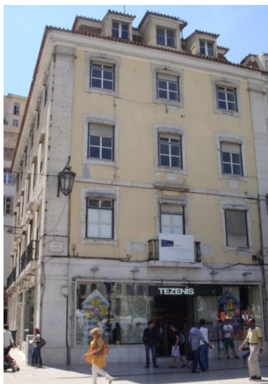
Fig. 3.2 – Eliminação de nembos para abertura de montra
