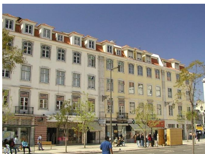
Fig. 2.27 – Cobertura com mansardas
