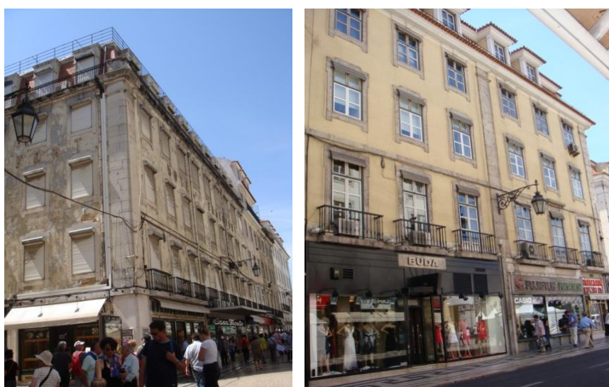
Fig. 2.18 – Edifícios pombalinos em Lisboa
