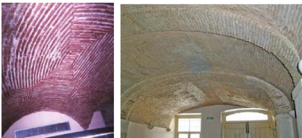
Fig. 2.13 – Exemplos de tectos abobadados e em arco no rés-do-chão [13, 3]
