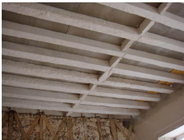
Fig. 4.21 – Tarugamento de vigamento
