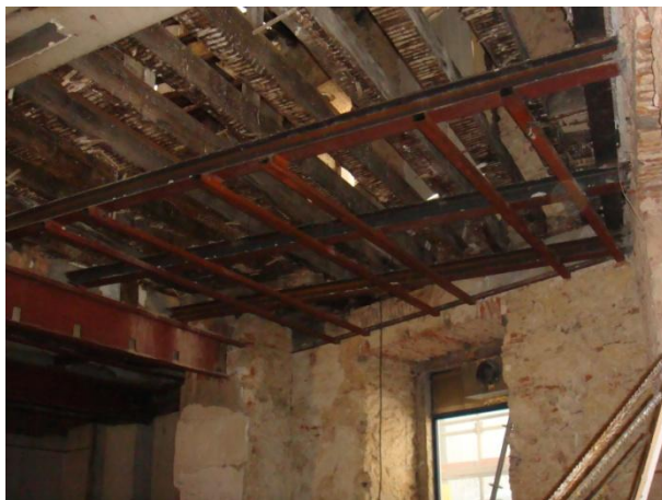
Fig. 5.10 – Estrutura metálica detectada no tecto do piso 0
