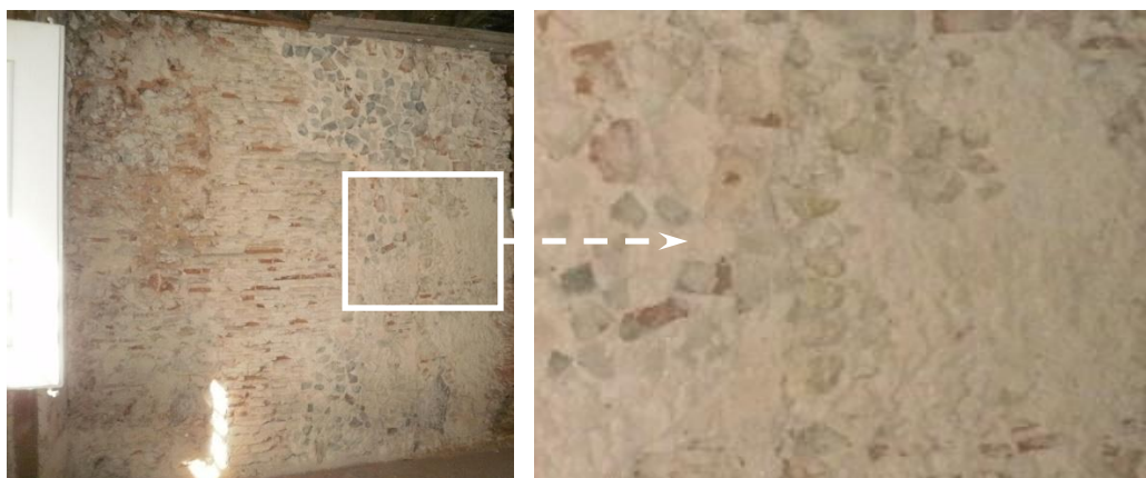
Fig. 2.10– Parede de alvenaria ordinária ou alvenaria de pedra tradicional (edifício em Lisboa)
