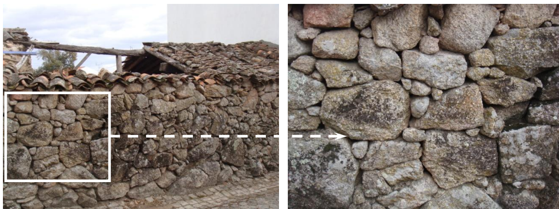
Fig. 2.9 – Parede de alvenaria de pedra seca (edifício em Idanha-a-Nova)
