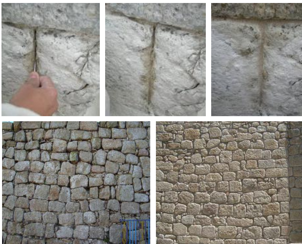
Fig. 4.8 – Refechamento de junta [67]
