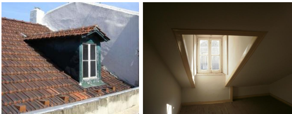
Esquerda: trapeira vista pelo exterior [37]; Direita: trapeira vista pelo interior
