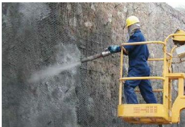
Fig. 4.15 – Betão projectado em estruturas antigas num encamisamento [16]
