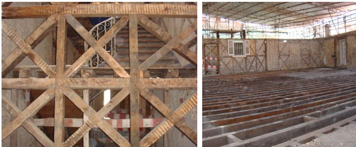
Fig. 5.4 – Estrutura em gaiola reconstruída e pavimento da cobertura do edifício
