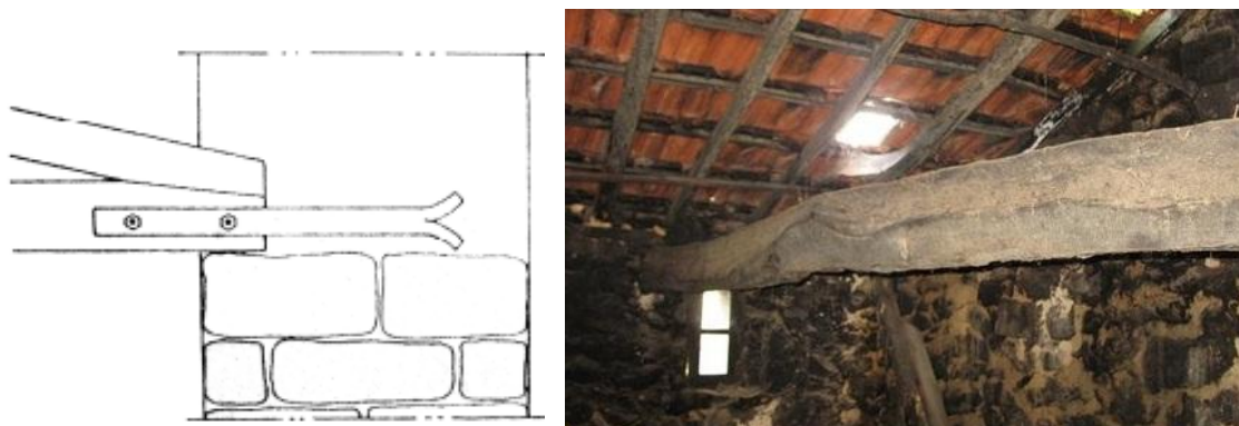
Esquerda: representação esquemática de esmagamento por excesso de carga vertical; Direita: imagem de esmagamento por torção por secagem da viga
