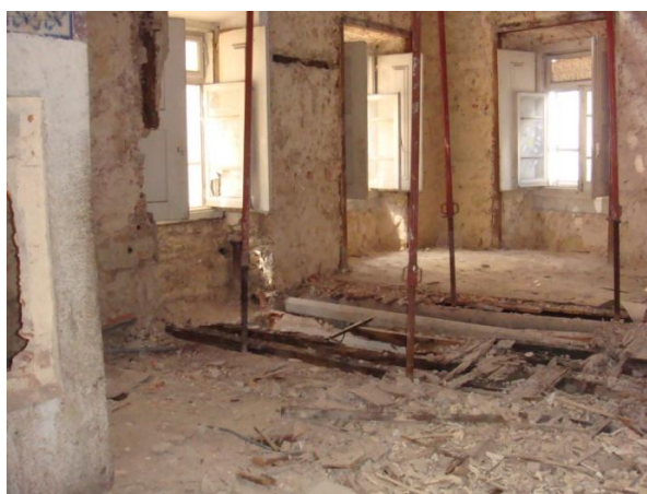
Fig. 5.9 – Desmonte dos pavimentos e paredes
