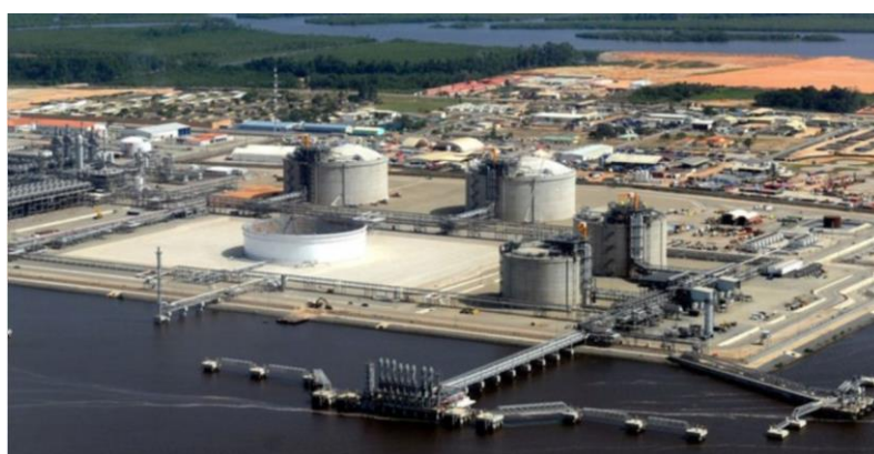
Figura 20 – Instalações de processamento de LNG em Angola
