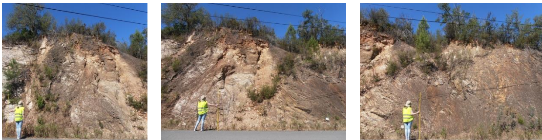
Figura 4.29 – Aspecto zona 5.2 do Talude 5 em Junho de 2014
