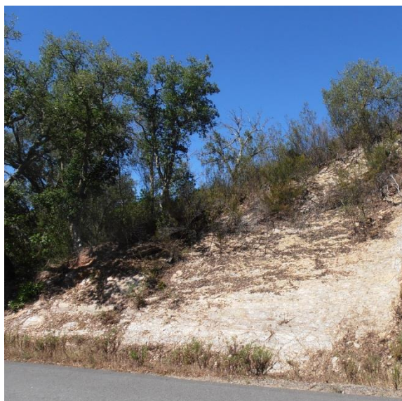
Figura 4.32 – Aspecto do Talude 5 em Junho de 2014: zona 5.5
