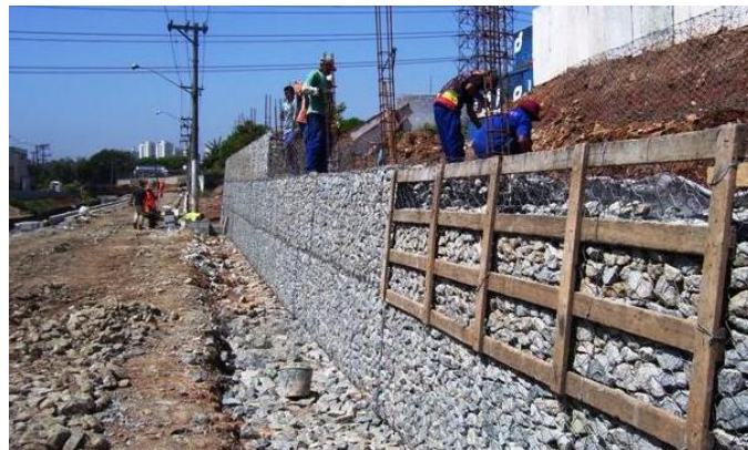
Figura 2.19 - Construção de um muro de gabiões
