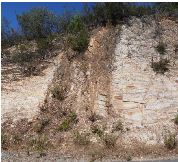
Figura 4.31 Aspecto da zona 5.4 do Talude 5 em Junho de 2014
