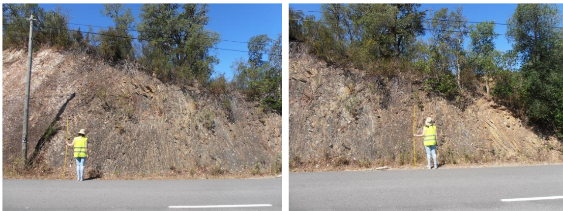
Figura 4.28 – Aspecto da zona 5.1 do Talude 5 em Junho de 2014
