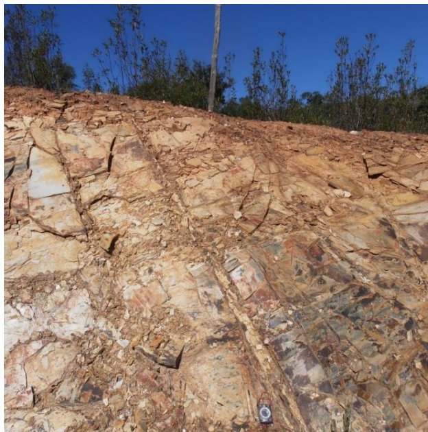
Figura 4.36 – Pormenor do talude 6 em Junho de 2014, ao centro com fenda preenchida por quartzo
