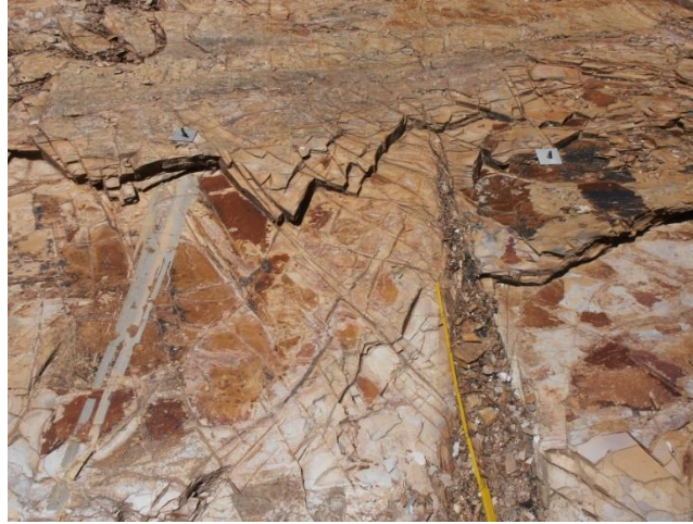
Figura 4.34 – Pormenor do talude 6 em Junho de 2014, onde se observa as pregagens aplicadas
