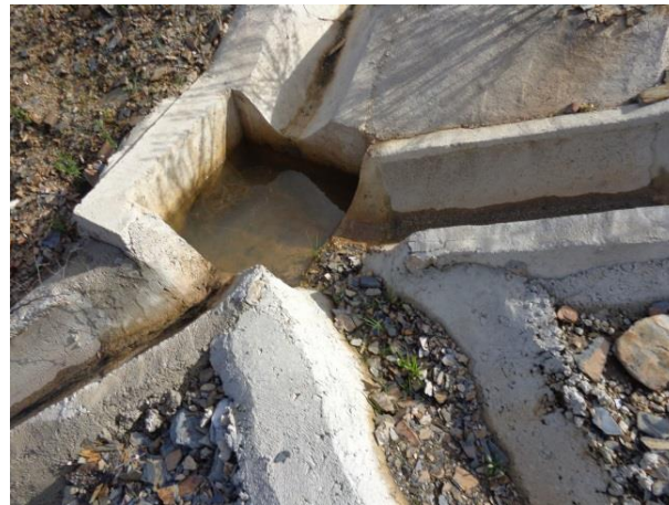
Figura 4.12 – Pormenor da colmatção de caixa colectora na zona 3.3 do Talude 3, Fevereiro de 2014
