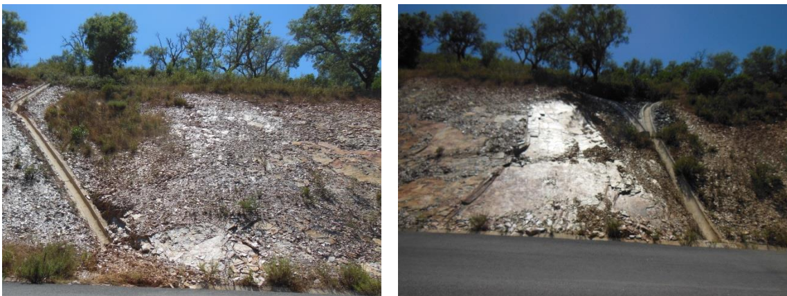
Figura 4.10 – Aspecto da 2ª zona do Talude 3 em Junho de 2014
