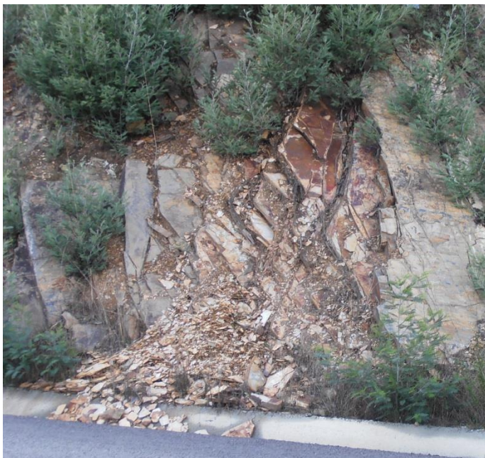
a) Material retido na valeta de plataforma
