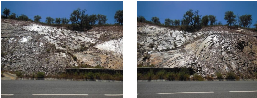
Figura 4.15 – Vista geral da zona 3.4 do Talude 3 em Junho de 2014
