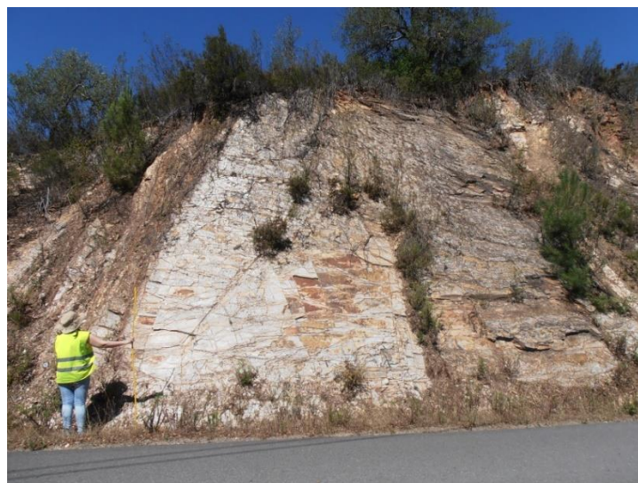
Figura 4.30 – Aspecto da zona 5.3 do Talude 5 em Junho de 2014
