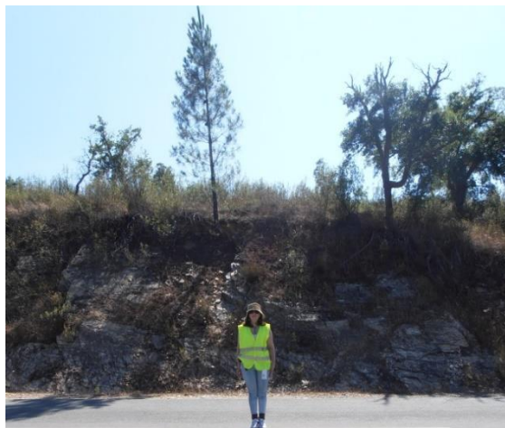
Figura 4.38 – Aspecto do talude 7 em Junho de 2014
