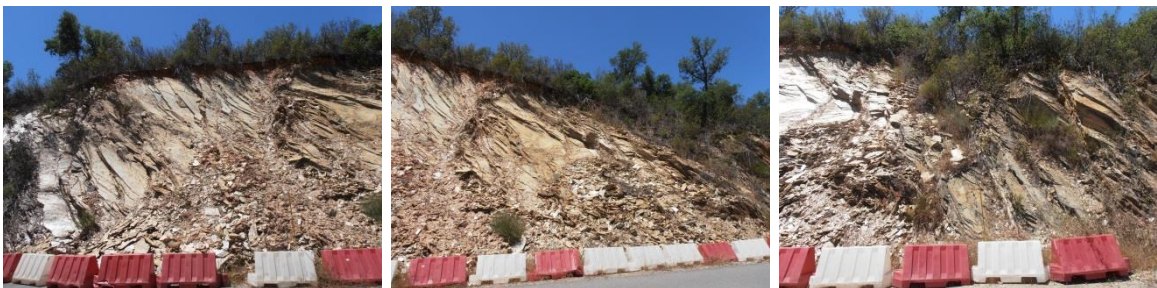
Figura 4.23 – Aspecto zona 4.4 do Talude 4 em Junho de 2014: instabilidade comandada por roturas do tipo planar
