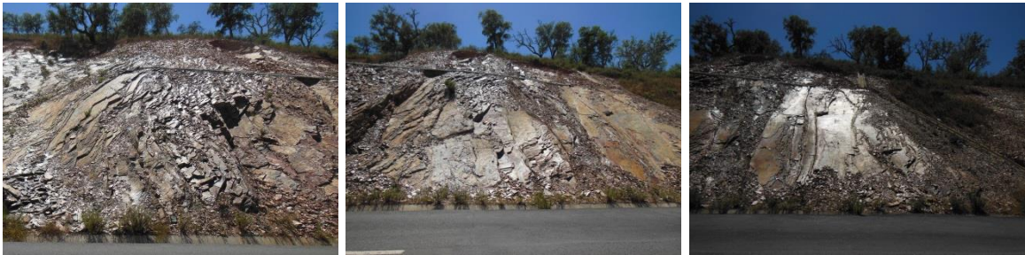
Figura 4.11 – Aspecto da 3ª zona do Talude 3 em Junho de 2014
