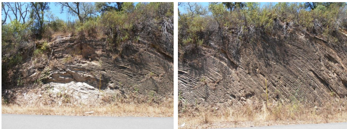
Figura 4.26 - Aspecto da zona 4.6 do Talude 4, em Junho de 2014, onde se observam dobras junto ao fim deste trecho com o núcleo em materiais competentes
