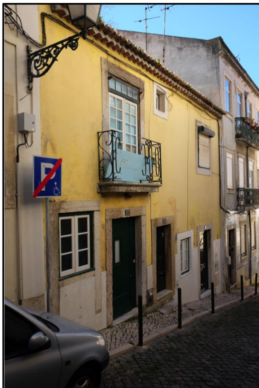
14. Rua do Carrião, nºs 17, 19 e 21
