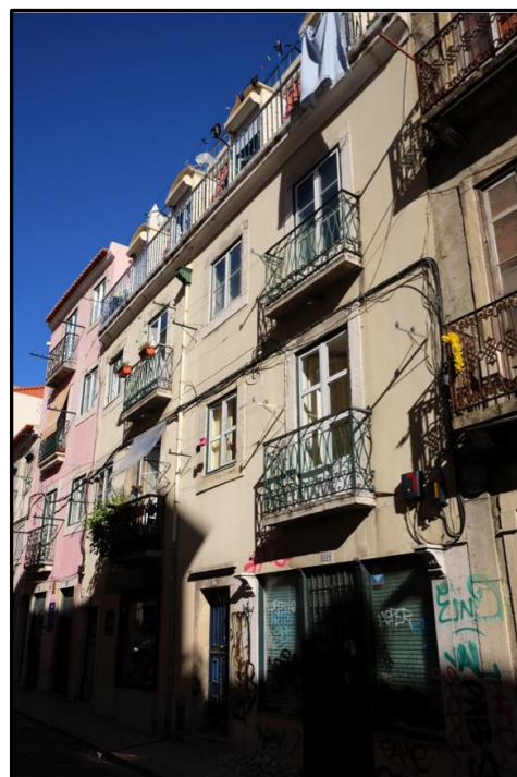
4. Rua de São José, nºs 112 a 124.
