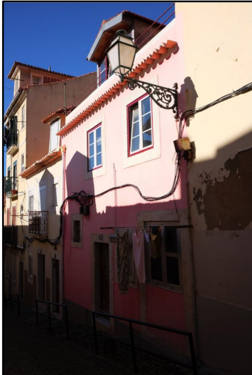
22. Travessa das Parreiras, nº 28.
