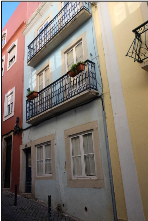
12. Rua da Fé, nº 11.
