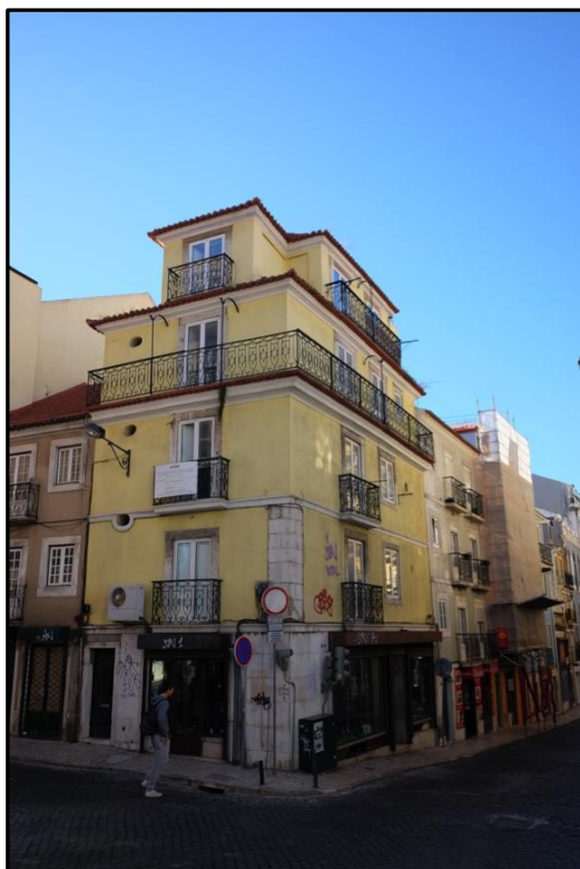
6. Esquina da rua de São José com a rua das Pretas.
