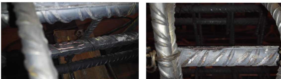
Figura 3.9 - Alisamento das armaduras para a colocação dos extensómetros.
