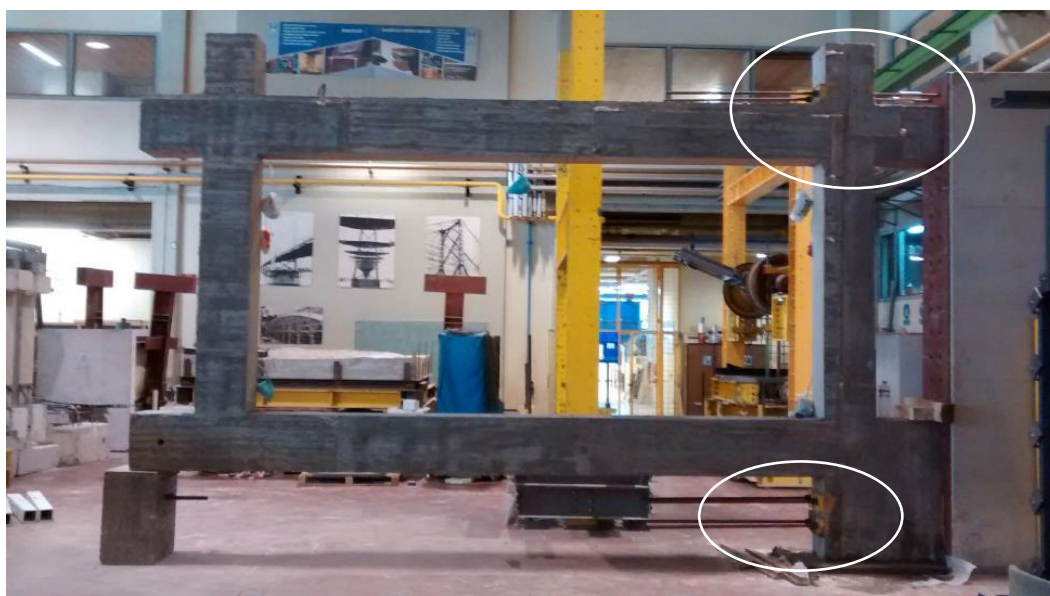
Figura 3.8 - Pré-esforço contra a parede de apoio do laboratório.
