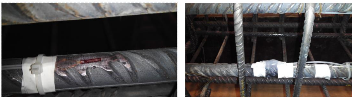
Figura 3.10 - Aplicação de cola e silicone para proteger os extensómetros.
