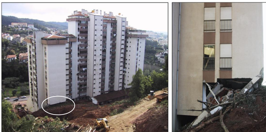
Figura 2.3 - Edifício danificado: fachada Oeste dias depois do acidente (à esquerda); detalhe do colapso dos pilares (à direita) (adaptado de [2]).
