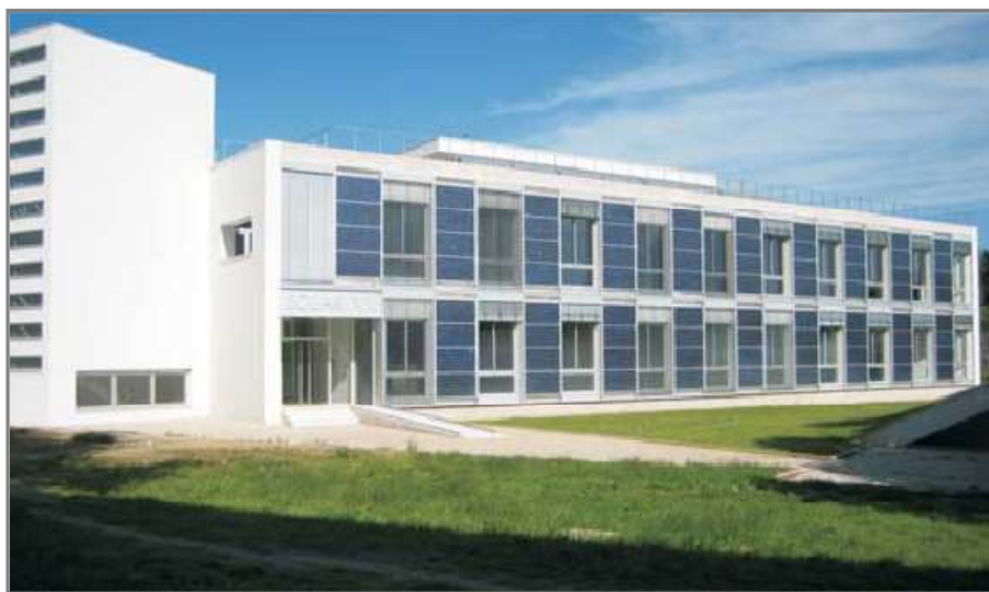
Figura 3.4. Fachada sul o Edifício Solar XXI. [27]
