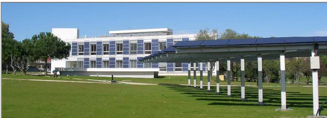
Figura 3.19. Aspecto dos módulos PV integrados na fachada sul e do parque de estacionamento do Edifício Solar XXI. [1]
