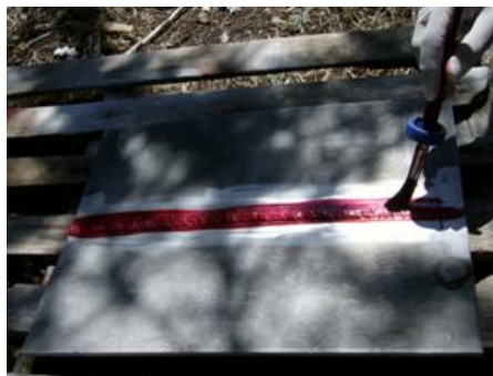
Aplicação do penetrante.
