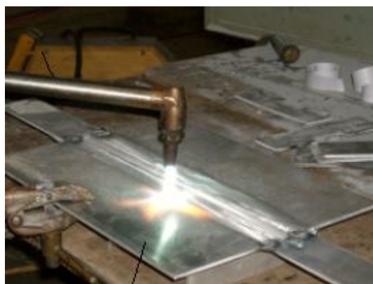
Etapa de pré-aquecimento da chapa.
