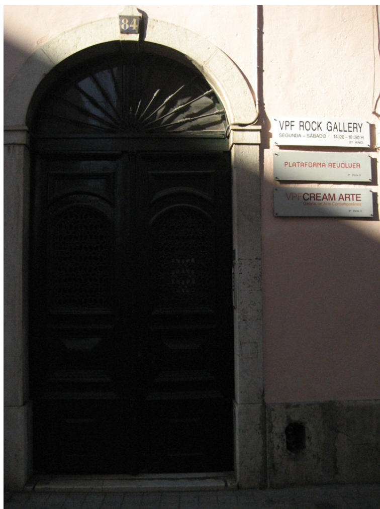
5. Entrada do Edifício Transboavista na Rua da Boavista, em Lisboa (Agosto 2010). Autoria: Sofia Campos.
