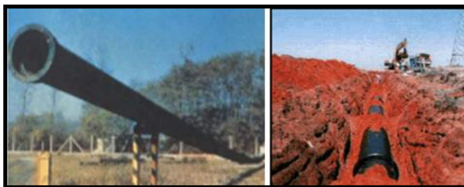
Figura 4. 13 - Ferro fundido dúctil e a Instalação da tubagem.
